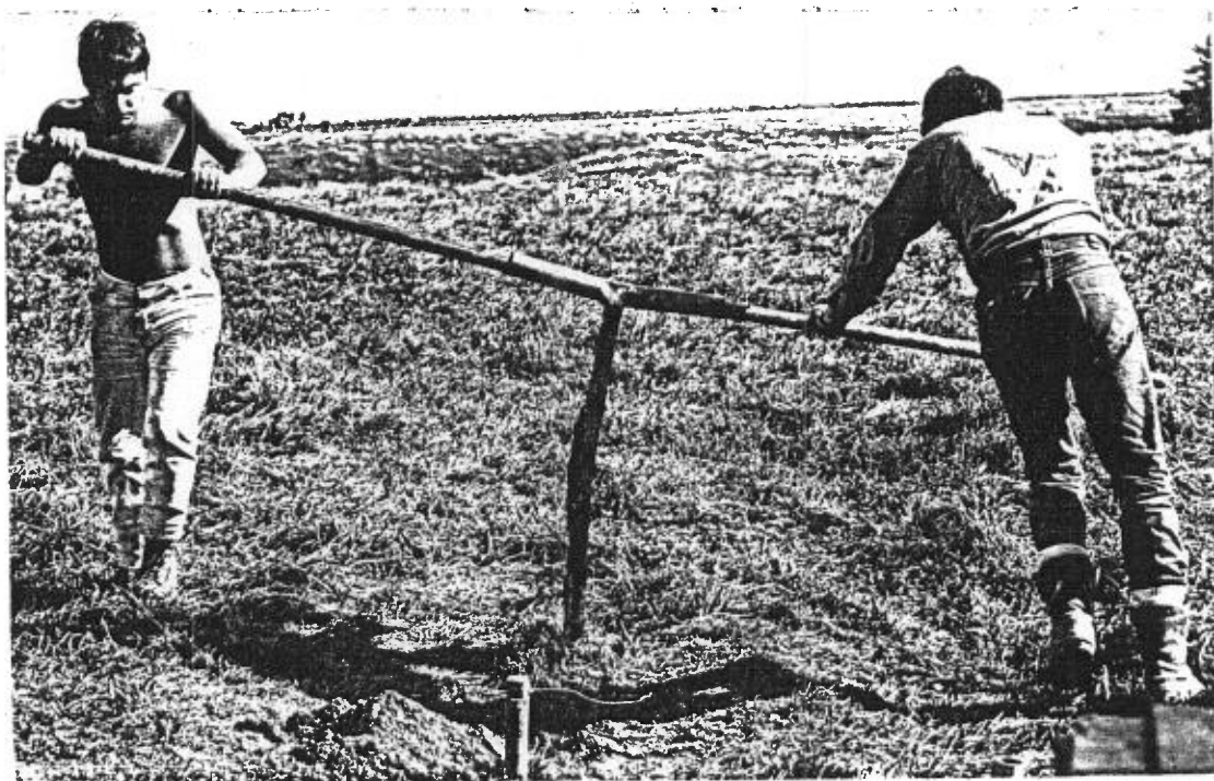
Photo No. 4 - Mise en place des vis d'ancrage
