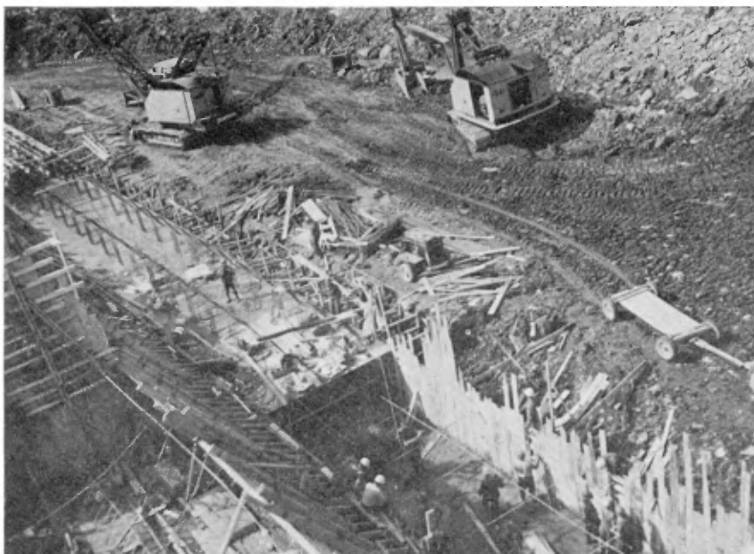
PLANCHE IV — Détail des dalles du radier aval et des dissipateurs d'énergie à trois différents stades de construction.
