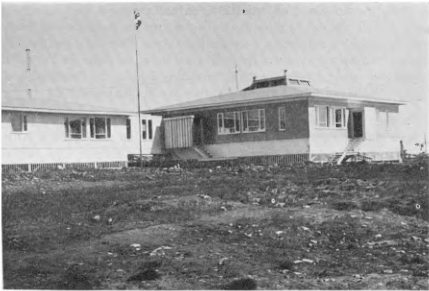
Le Centre gouvernemental du Québec à Povungnituk, qui fut terminé en avril 1966 et incendié le 30 décembre 1967.
