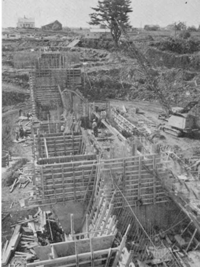
PLANCHE III — Vue générale vers l'ouest montrant l'érection des coffrages selon la méthode des levés successifs.
