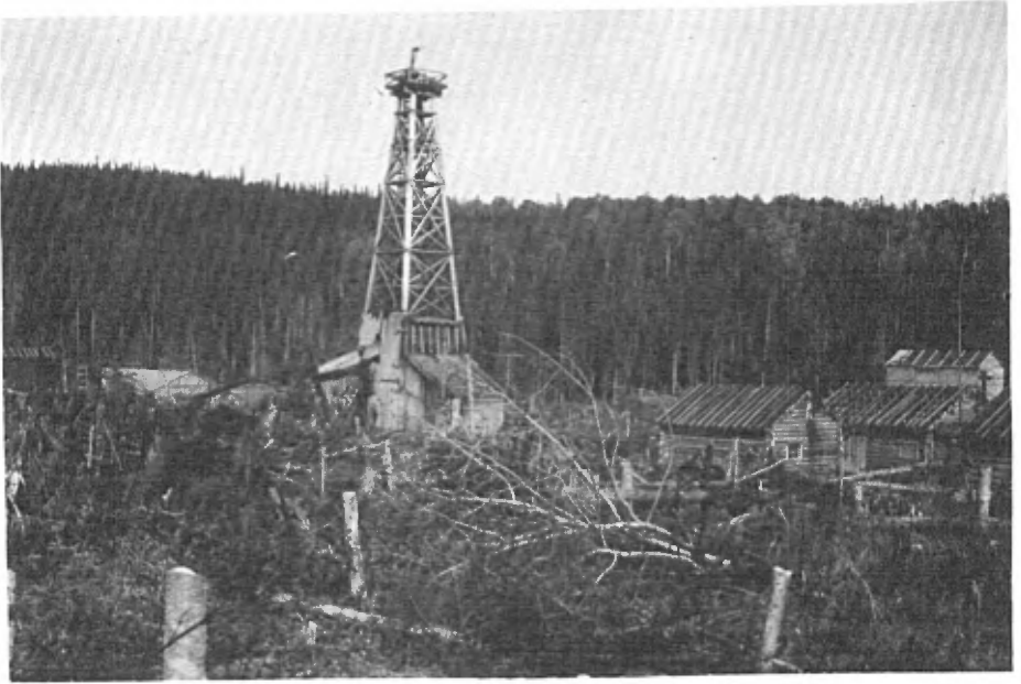
A.—Puits Mississippi No 1.
