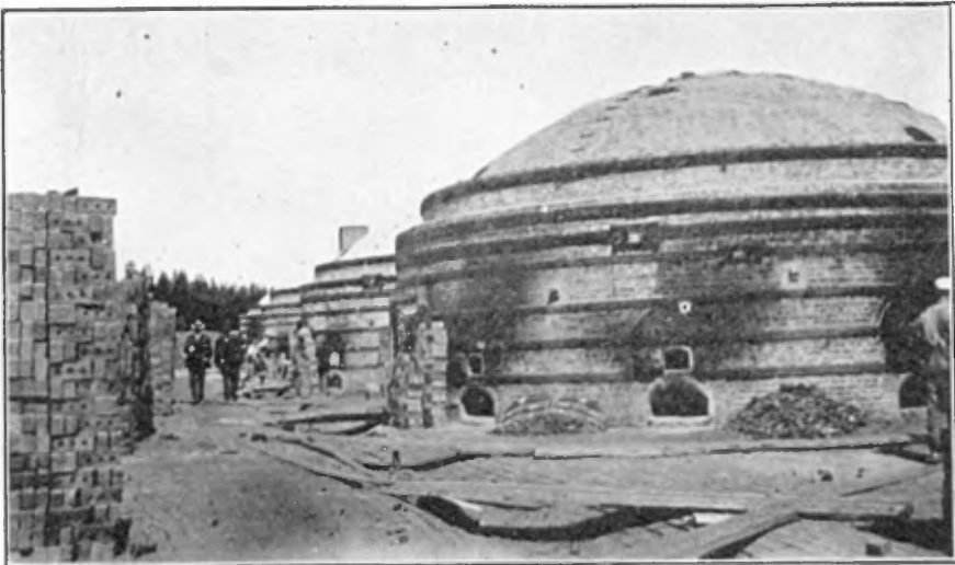
La Brique de Scott, Limitée.—Fours circulaires à tirage descendant, à Scott Junction,
