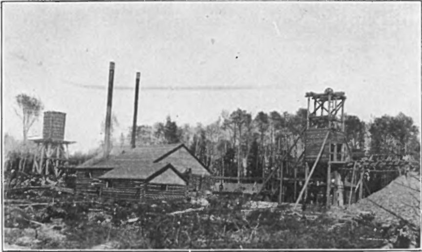
Canton de Dubuisson.—Installation de la Union Mining Corporation.
