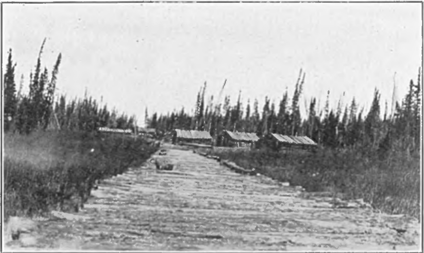
Parties marécageuses de la zone aurifère, requérant des chemins pontés "corduroy".
