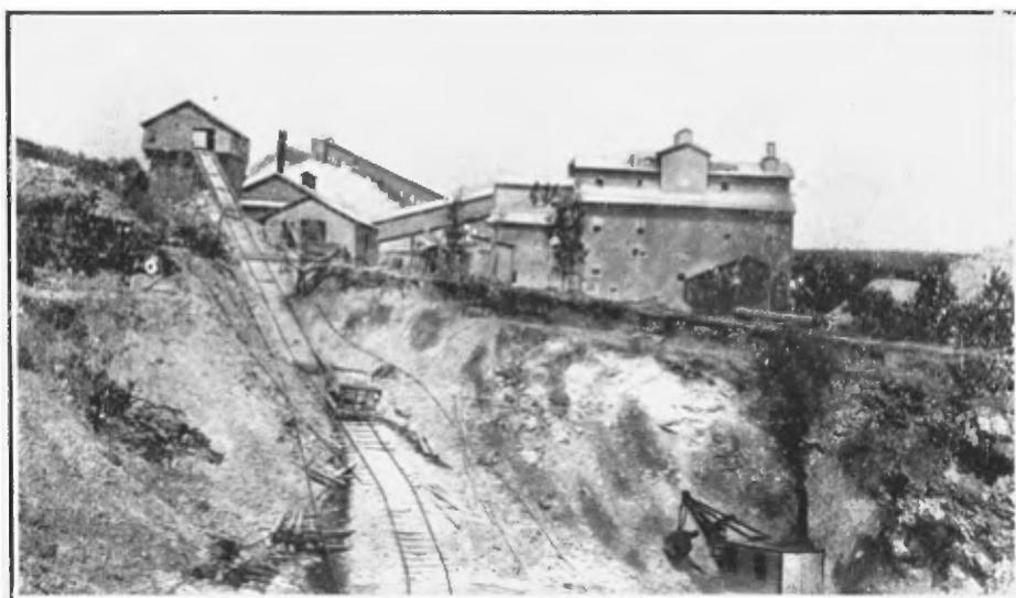
ASBESTOS FIBRE MINING CO. LTD.—East Broughton, P. Q.—Méthode d'extraction par pelle à vapeur et plan incliné.
