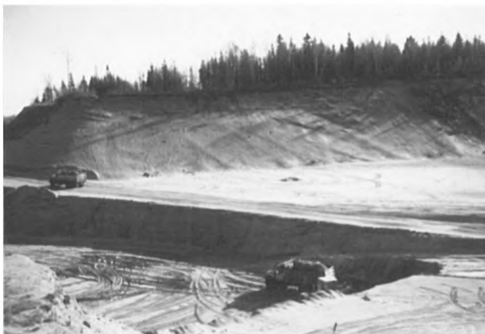
Photo 9 : Vaste exploitation (P.E.B.) à l'intérieur de la moraine du lac Saint-Charles. Le matériau, plus de 20 m d'épaisseur de sable stratifié, a été remanié par la mer Champlain (banc 69, gisement 16)
