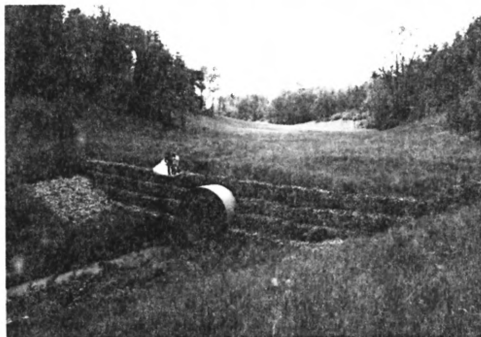
Figure 38: Travaux correcteurs réalisés au ruisseau des rangs II, III et IV (Templeton) près de la traverse de l'Autoroute 50.
