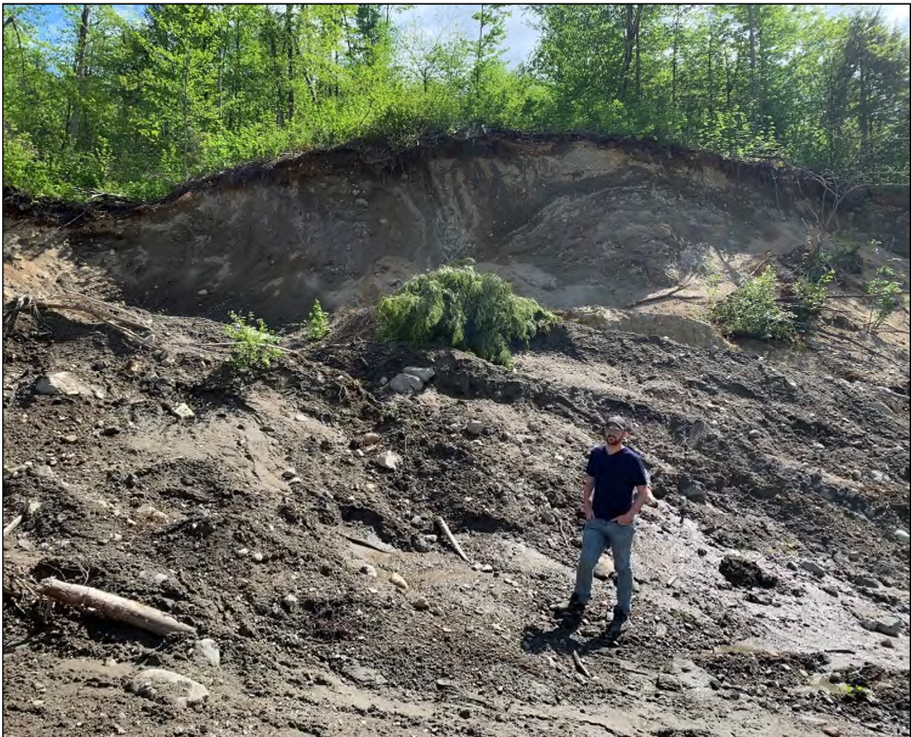
Figure 49 | Exemple de dépôts de versant indifférencié à la station #75 (EB0522075).
