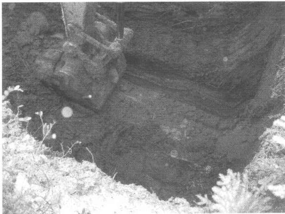
Creusage des puits d'échantillonnage
