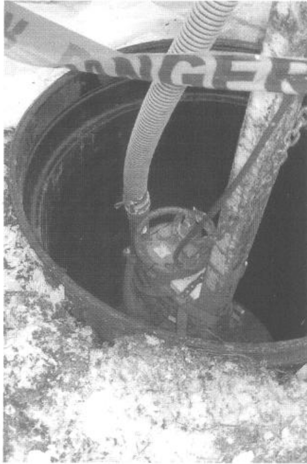
Figure 12 : Pompe mise en place dans le «caisson» pour le test in situ
