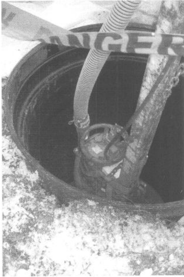
Insertion de la pompe d'essai # 1
