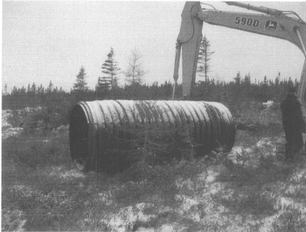
Puits de pompage de l'argile
