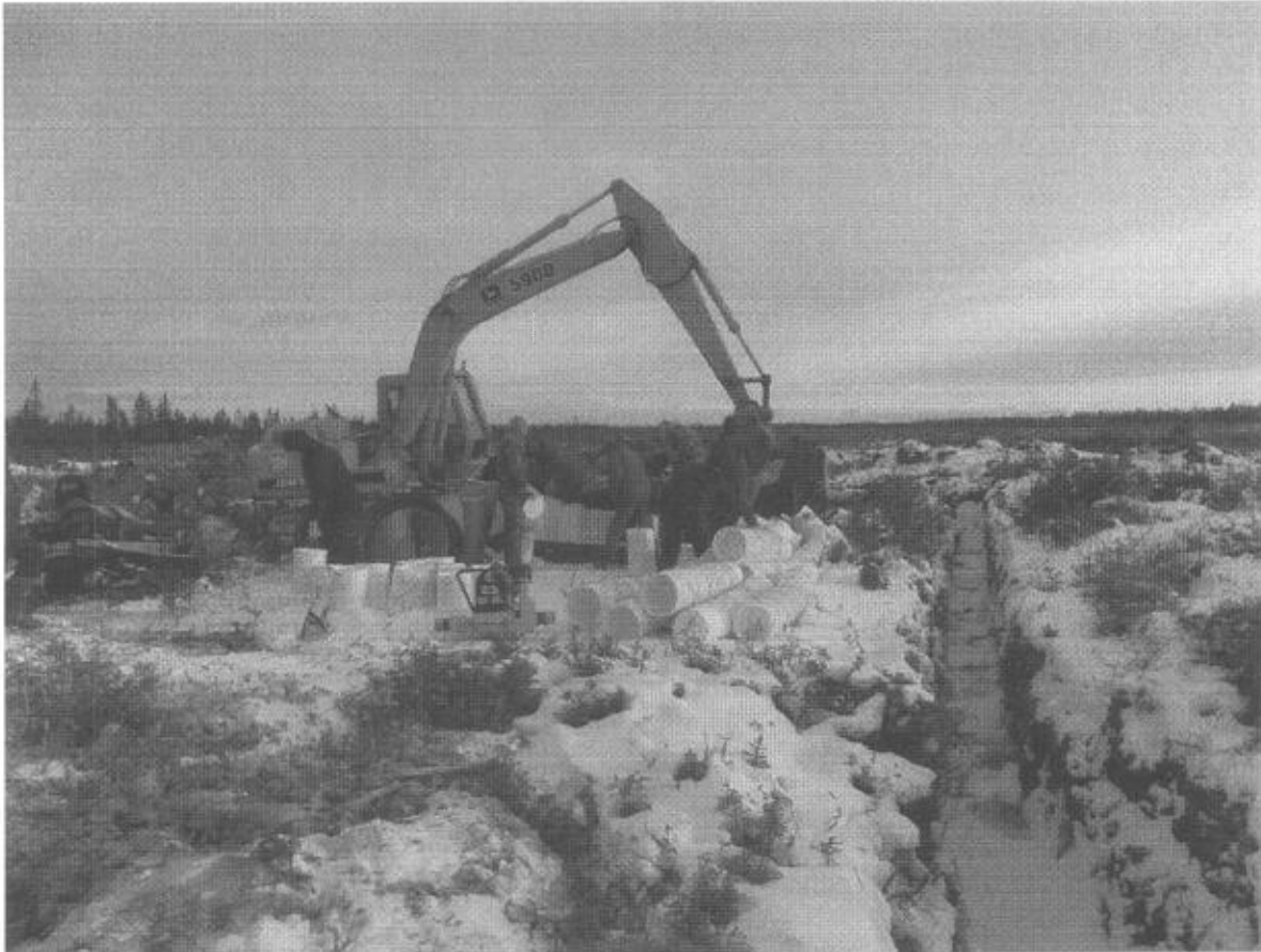
Figure 14 : Vue d'ensemble de l'opération d'extraction réalisée de façon «traditionnelle»
