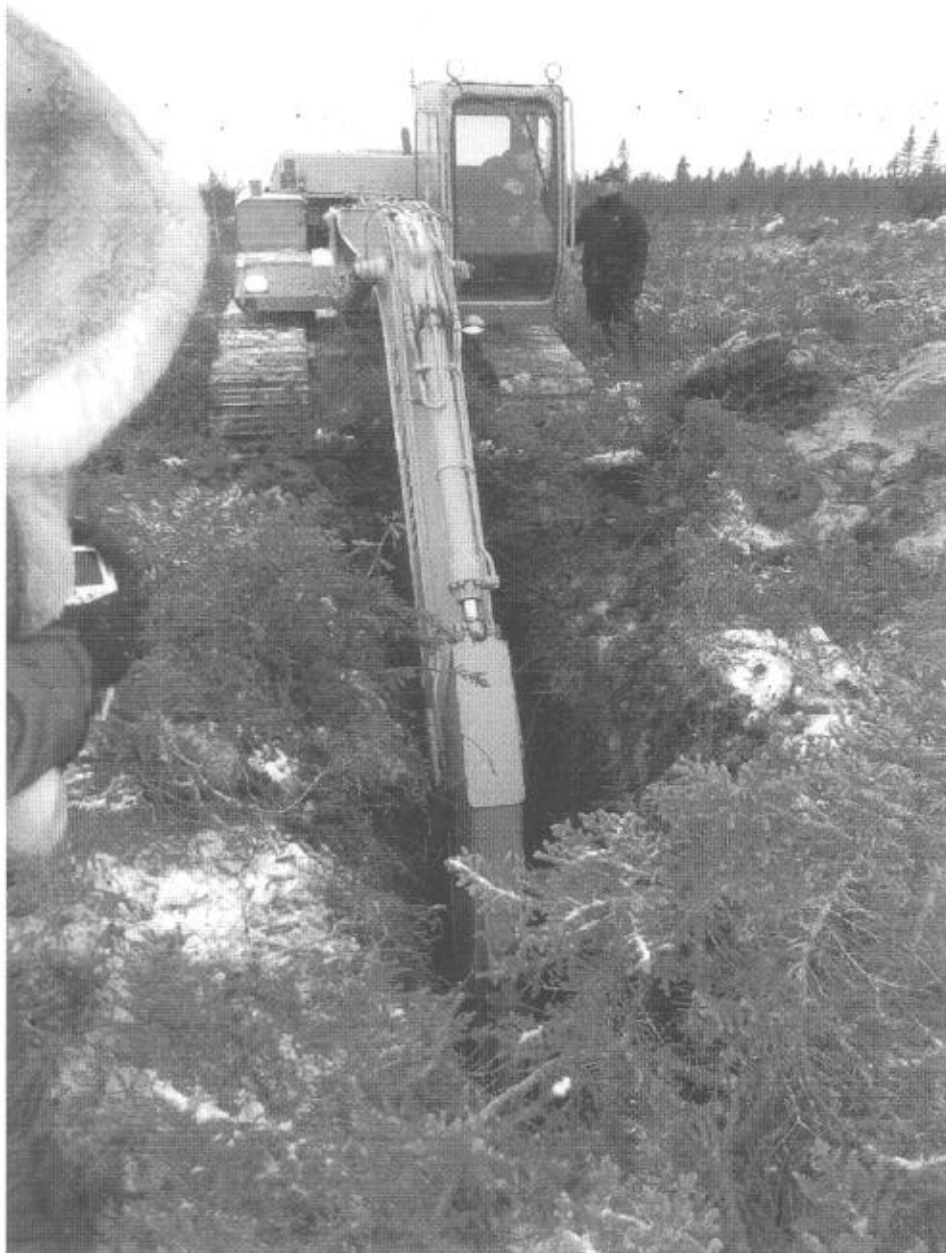
Figure 9 : «Sondage» avec excavatrice, #01
