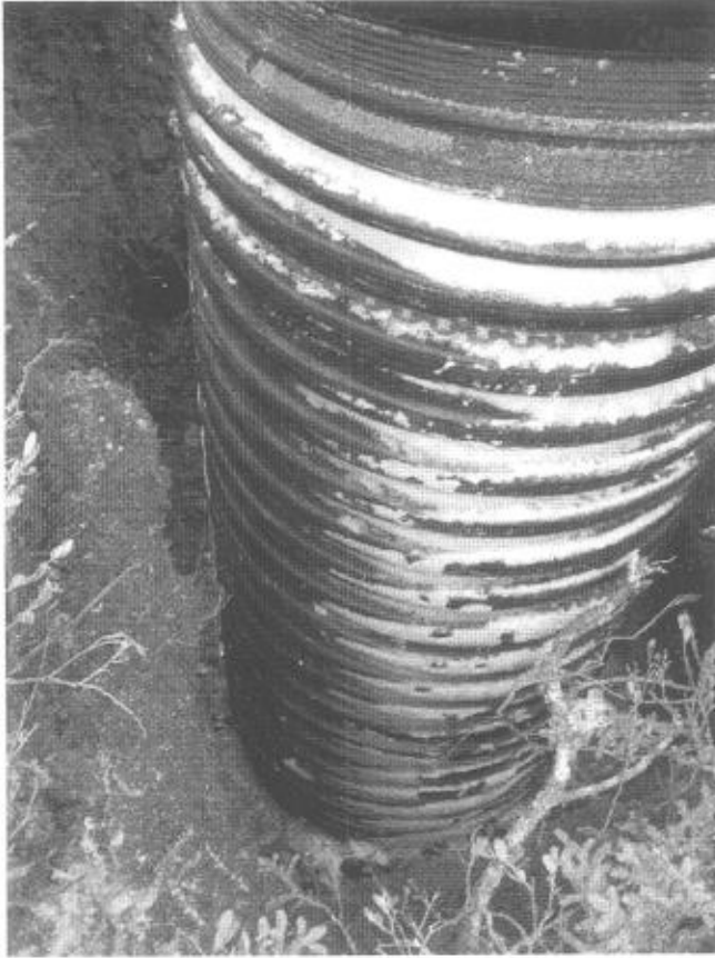
Installation du puits de pompage
