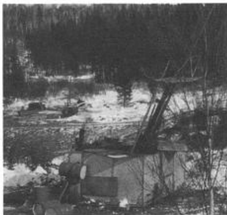
Travaux de forage qui ont mené à la découverte de la Mine Doyon.
