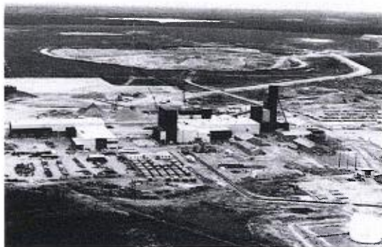
Chevalement du puits de mine de la zone B et autres installations de Mines Selbaie.
