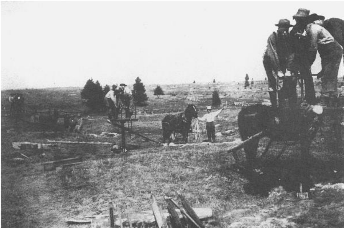
FIGURE 1A - Dominion Gold Fields: Forage dans les sédiments meubles au voisinage de la rivière Gilbert à l'aide de sondes Empire (Dresser, 1911).
