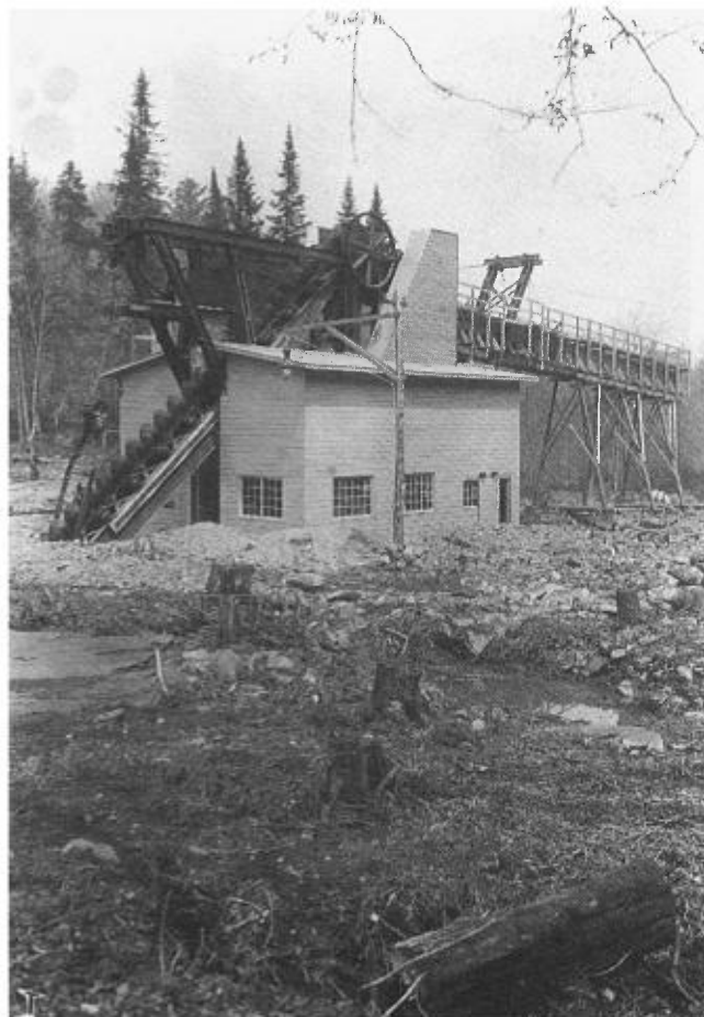
FIGURE 1G - Dominion Gold Fields Ltd. Elévateur et plate-forme pour le transport et l'accumulation des résidus en vue d'un nouveau lavage (pour échelle, voir le cheval) (Dresser, 1911).
