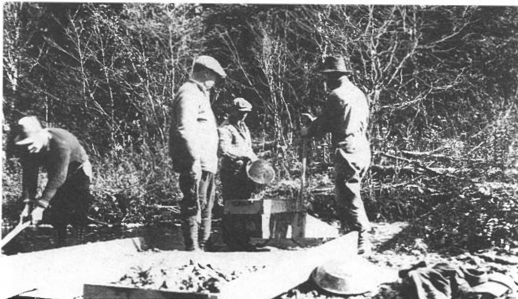
FIGURE 4 - Opération d'un rocker (berceau) dans le canton Ditton en 1933.
