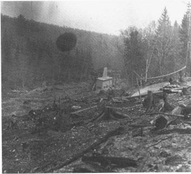
FIGURE 1D - Dominion Gold Fields Ltd. Délavage d'une pente vers le sluice à l'aide d'un ajutage (voir Levat, 1905, page 360). Au fond, on aperçoit l'élévateur et la plate-forme où les résidus sont passés dans un autre sluice pour récupération de l'or fin.
