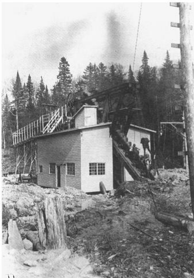
FIGURE 1F - Dominion Gold Fields Ltd. Elévateur et plate-forme pour le transport et l'accumulation des résidus en vue d'un nouveau lavage (on peut apercevoir trois mineurs sur l'élévateur) (Dresser, 1911).
