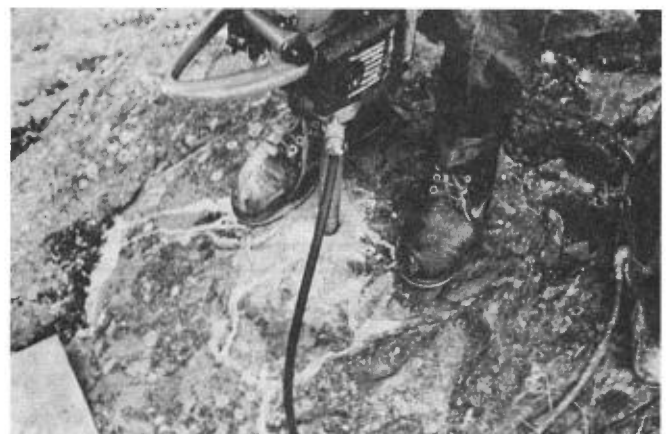
FIGURE 4 - Foreuse portable avec trépan à diamants en opération.
