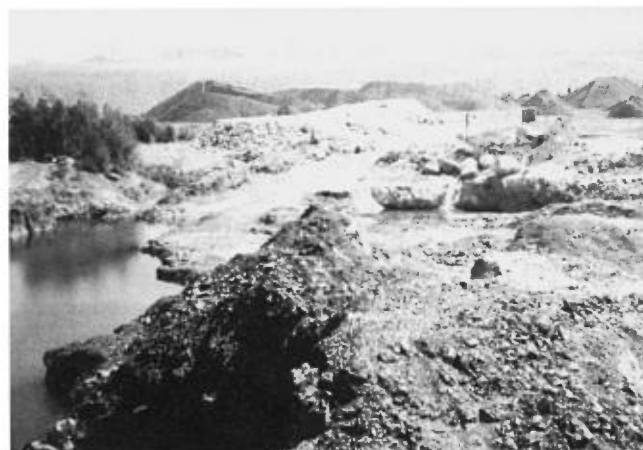
FIGURE 44 - L'excavation à ciel ouvert de la mine Bignell, à l'automne 1978.
