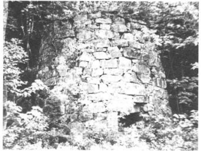
FIGURE 49 - Ancien four à chaux à la Grande Anse, à 1 km au NE de l'embouchure de la rivière du Moulin à Baude.
