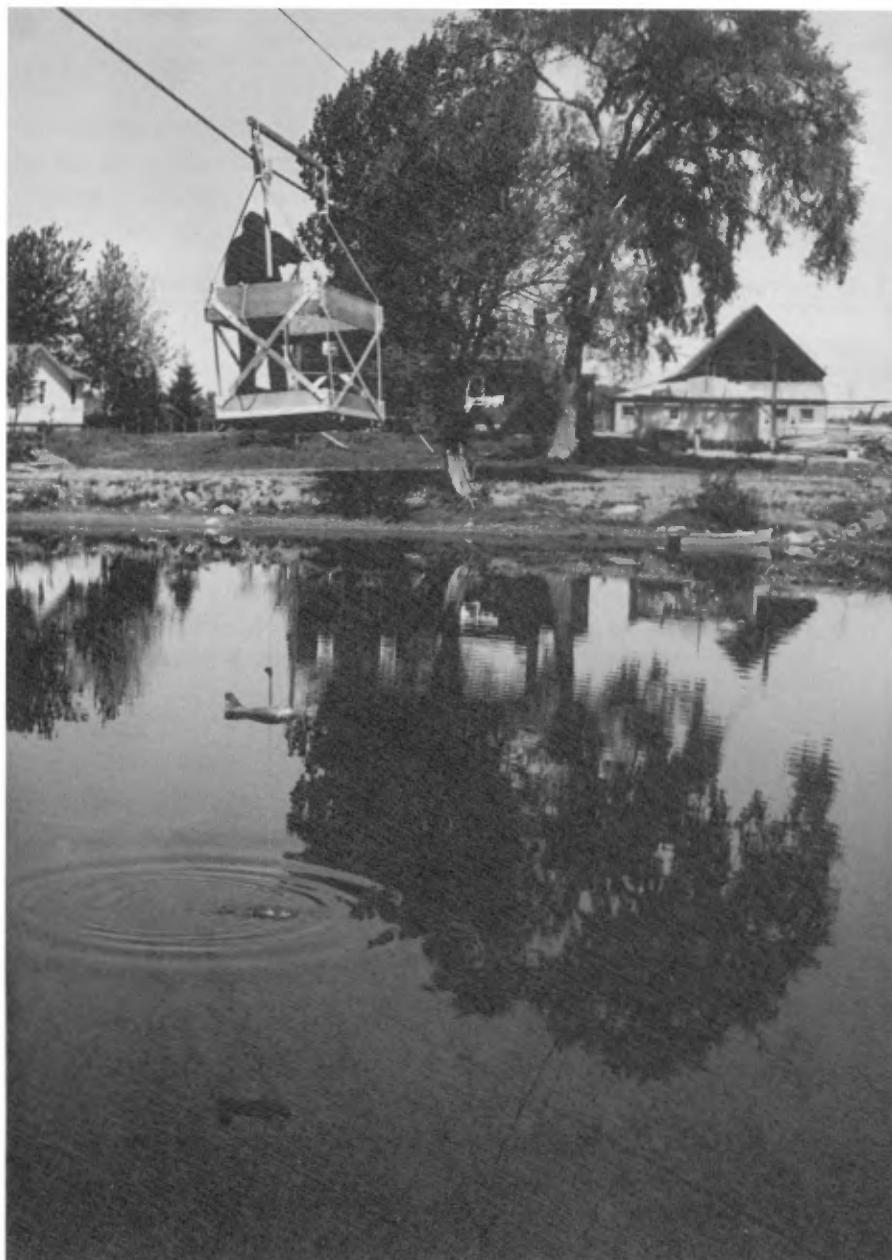
**Mesure des sédiments en suspension; échantillonnage à partir d'un transbordeur aérien.**
