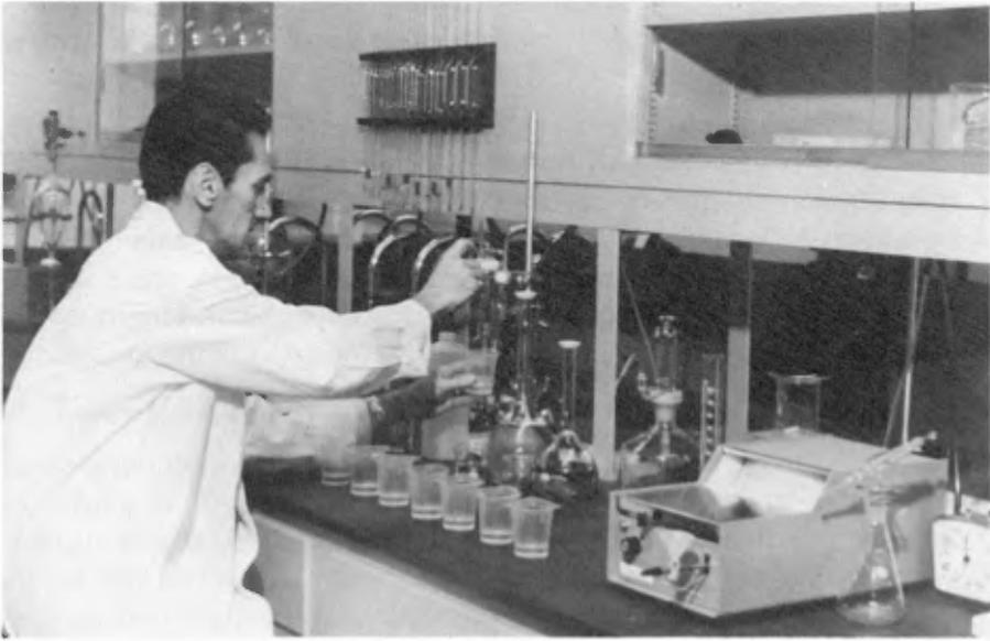
**Jaugeage par la méthode de dilution, au laboratoire, détermination du débit par méthode colorimétrique.**
