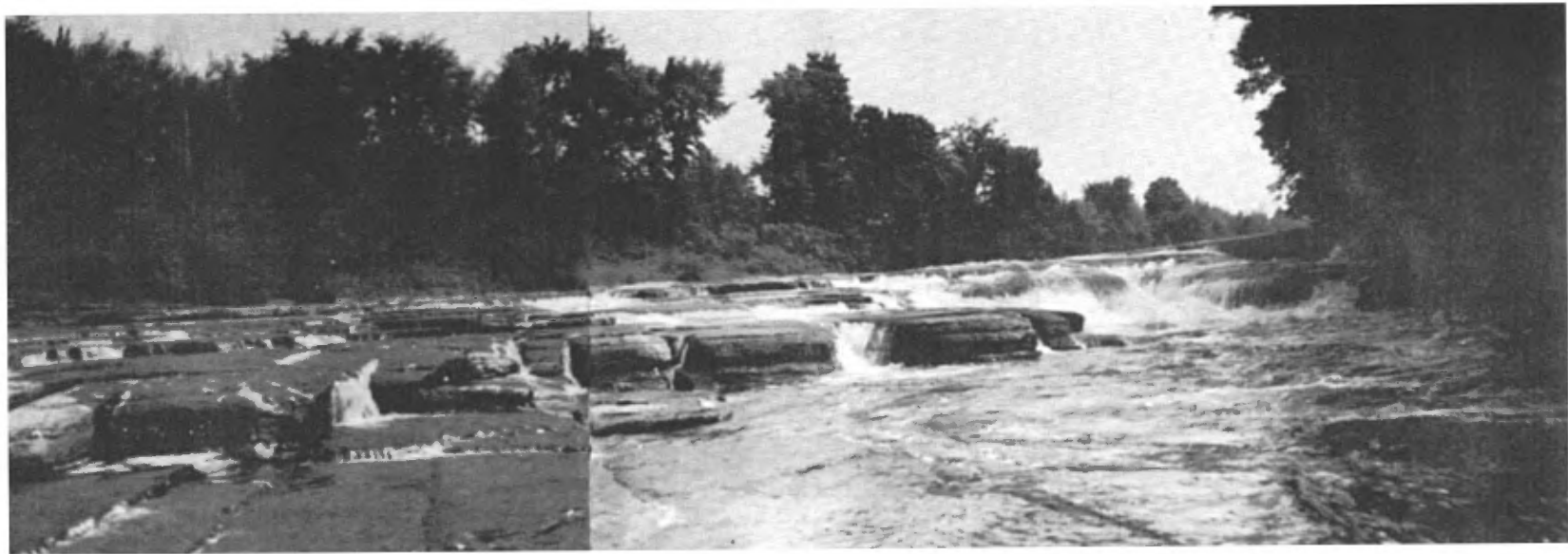
FIGURE 7 - Terrebonne facies on L'Assomption river, 1\frac{1}{2} miles northeast of Saint-Paul-d'Industrie. Note the regular jointing in the limestone./ Faciès de Terrebonne sur la rivière L'Assomption, à 1\frac{1}{2} mille au nord-est de Saint-Paul-d'Industrie. Noter le système régulier de diaclases dans le calcaire.
