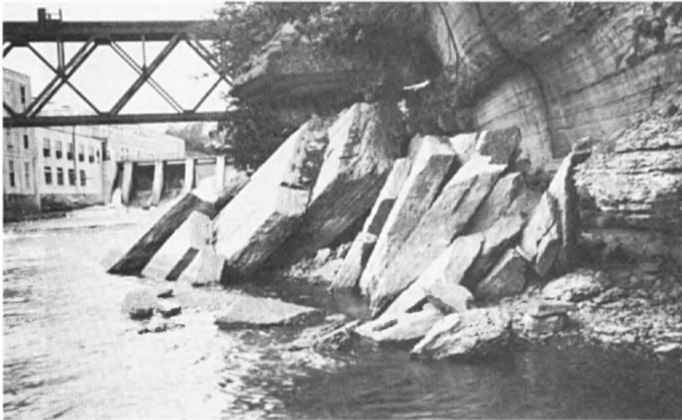
FIGURE 13 - Other view on site of Figure 12 to show blocks of Terrebonne limestone fallen from overhanging cliff / Autre vue au site de la figure 12 montrant les blocs de calcaire Terrebonne détachés de la partie surplombante de la falaise.
