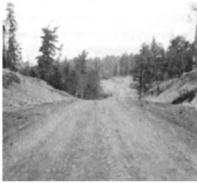
FIGURE 29 - Matériel hétérogène au sommet de l'esker au sud du barrage Bourque./Heterogeneous material at the top of the esker located south of Bourque dam.
