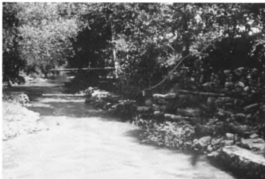
FIGURE 34 - Formation de Ouareau. Affleurement Ouareau en aval du barrage montré à la figure 33. /Ouareau Formation. Exposure downstream from the dam shown in Figure 33.
