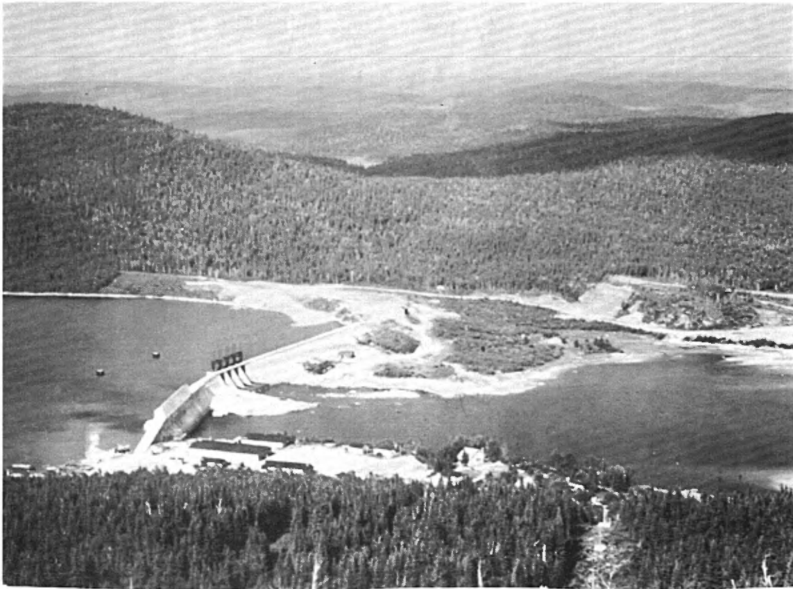
Vue du barrage Gouin prise de la tour 0/. A noter la surface ondulée de la pénéplaine environnante.
