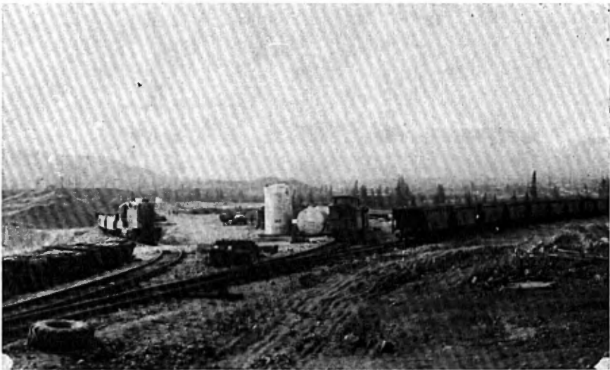
B — Travaux de ballastage au mille 84. Le sandur dans la vallée de la rivière Wacouno donne un gravier de bonne qualité.
