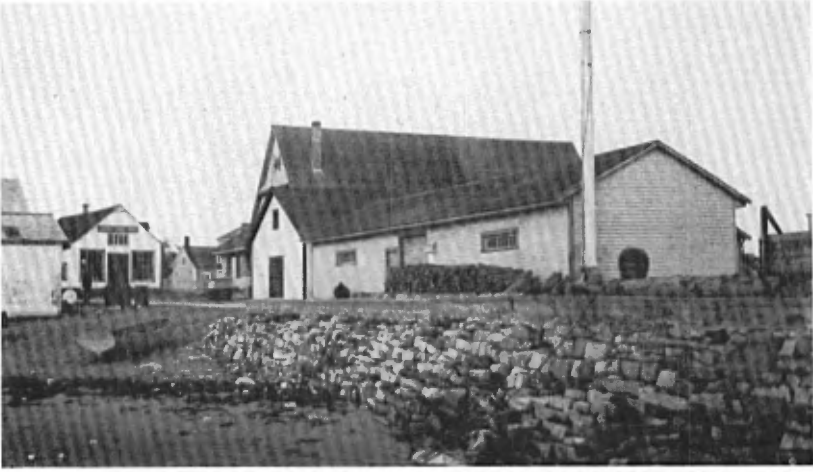
A—Dock à Havre St-Pierre. De droite à gauche, entrepôts du gouvernement, établissements frigorifiques, magasin général de "Labrador Fisheries".
