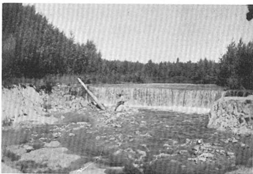
Planche IX. —Chutes d'argile, à 300 pieds en aval du barrage entre les lacs Desvaux et Ogima.
