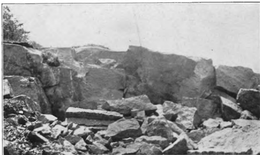
A.—Carrière abandonnée de La Granit Noir, Limitée, Saint-Gédéon, montrant les trainées dans la pierre et le caractère des cassures.
