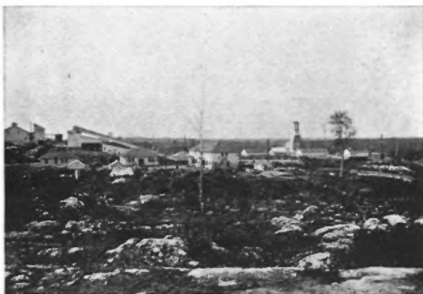
A.—Vue générale de l'installation de surface, mine Beattie.
