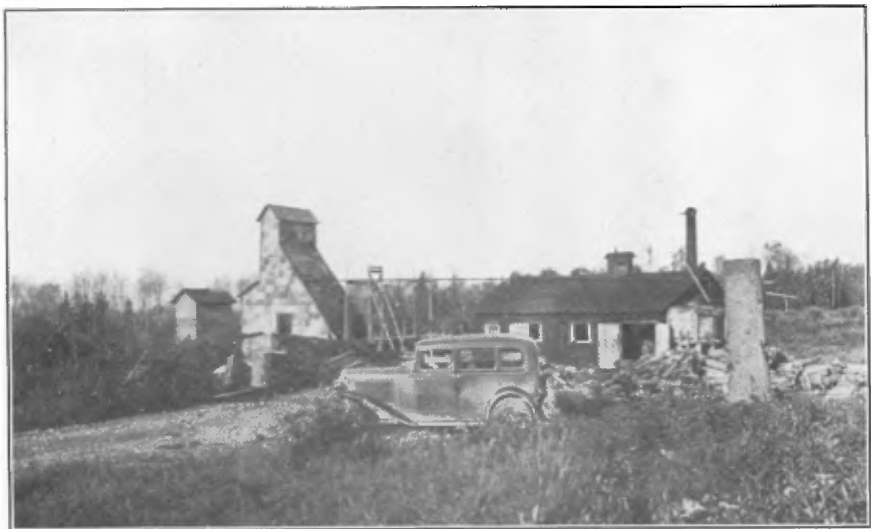
Mine Arntfield, puits No. 2, Est.
