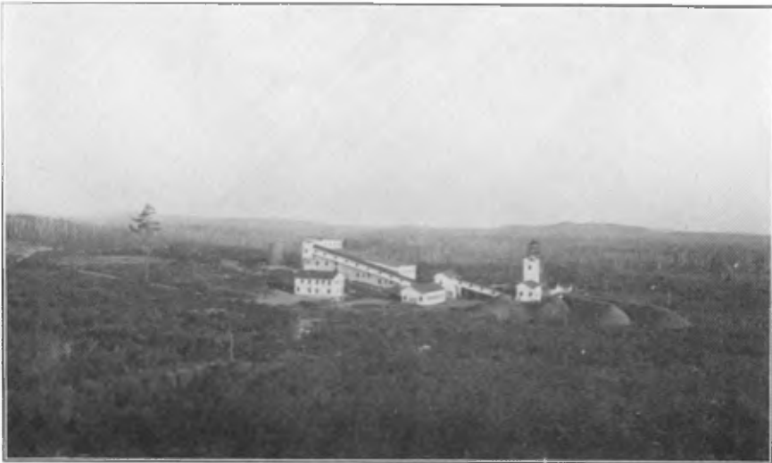
Chevalement et atelier de la mine Aldermac.
