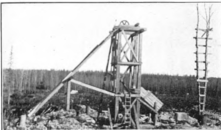
Abana Mines, Ltd. — Chevalement sur le lot 43, rang IX, canton de Desmeboizes.
