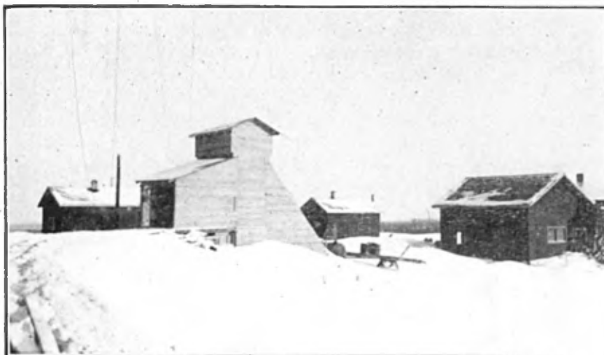
Jay Copper Gold Mines, Ltd. — Chevalement et abri du treuil d'excavation, canton de Dalquier.
