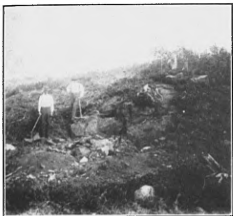
Premiers travaux, mine Desgrobois.
