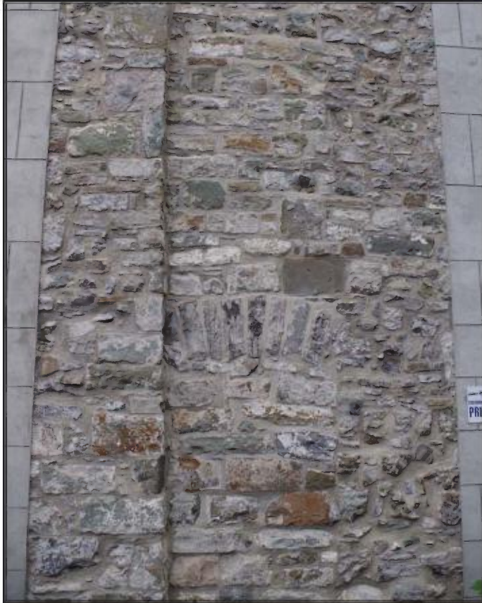
Morrin Centre : maçonnerie sous le crépi formée de moellons de calcaire de Beauport et de grès de Sillery.
