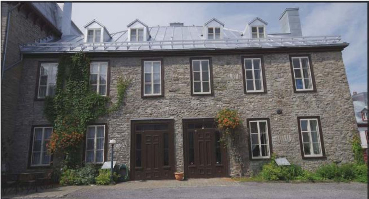
Pavillon de la prison des femmes : appareil irrégulier en moellons de calcaire de Beauport.
