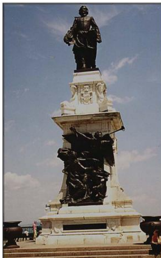
Monument de Samuel de Champlain : piédestal en calcaire de Château-Landon de France et emmarchement en granite des Vosges de France.
