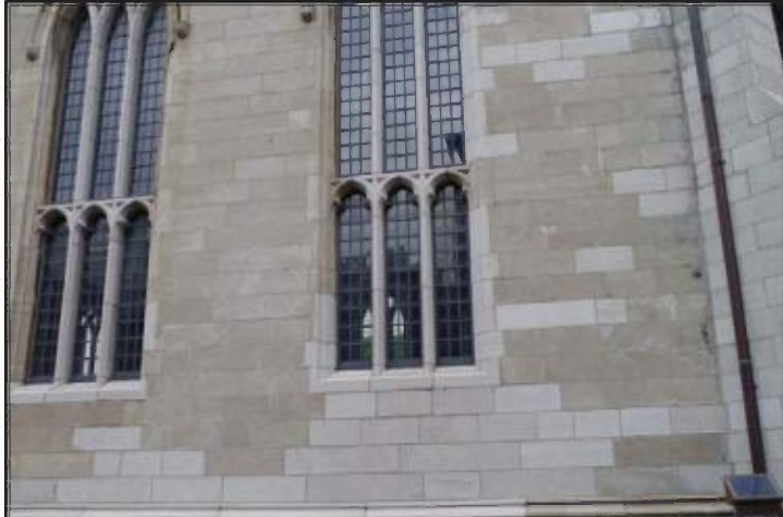
Mur de la rue Dauphine : pierres de taille à patine jaunâtre en calcaire de Montréal; pierres de restauration blanchâtres en calcaire de Saint-Marc-des-Carières.
