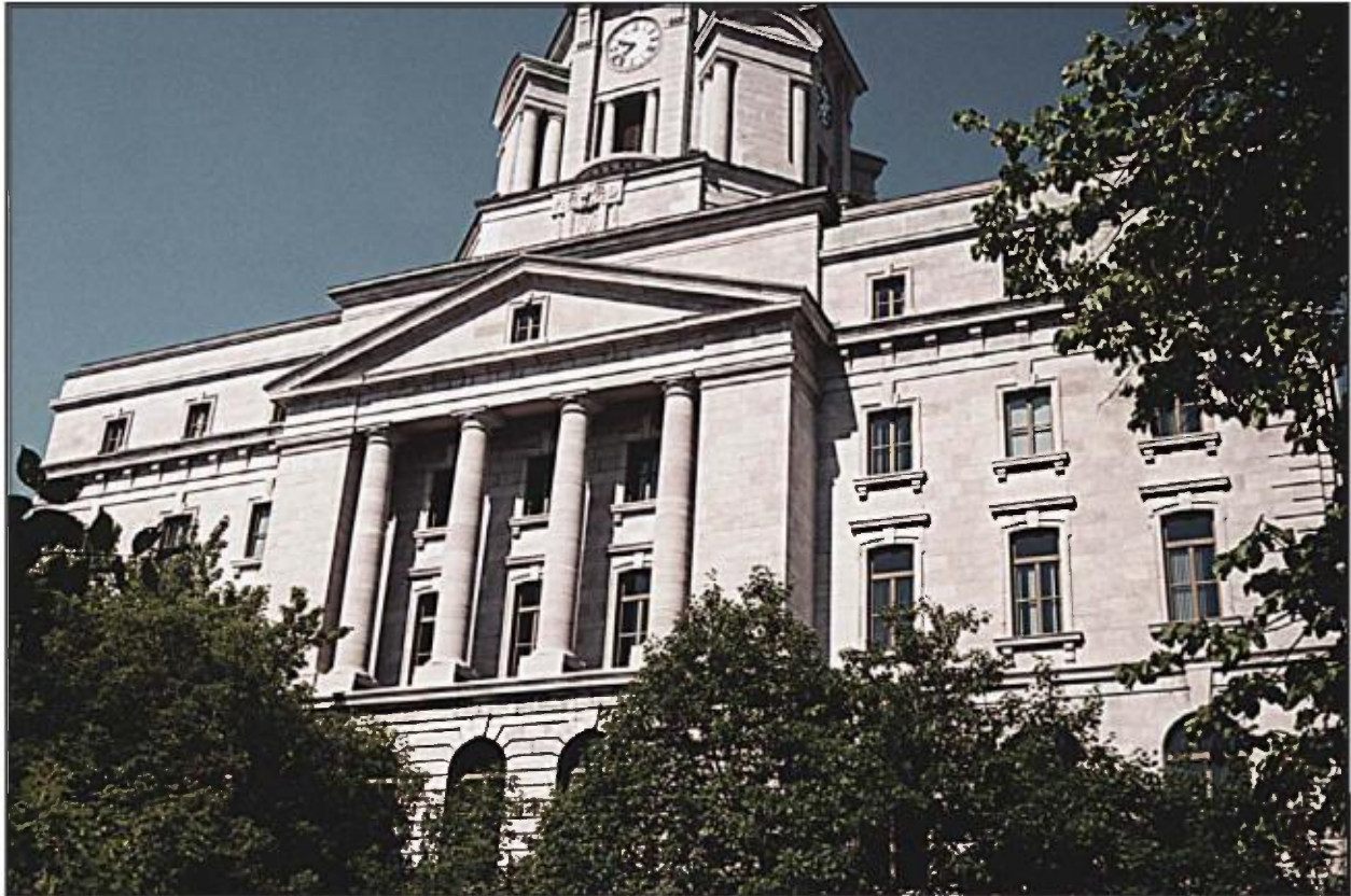
Édifice Louis-S.-St-Laurent : façade et coupole avec regard vers le fleuve construites en 1913, en calcaire de Saint-Marc-des-Carières.
