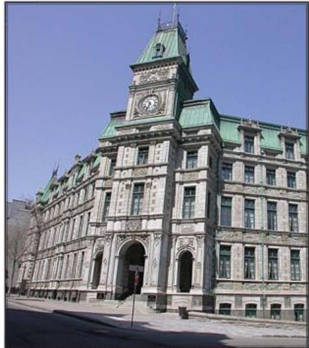
Ancien palais de justice de Québec : revêtu de grès brun jaunâtre et verdâtre de La Malbaie, de calcaire de Saint-Marc-des-Carières, de grès de Sillery et de granite Gris Stanstead.
