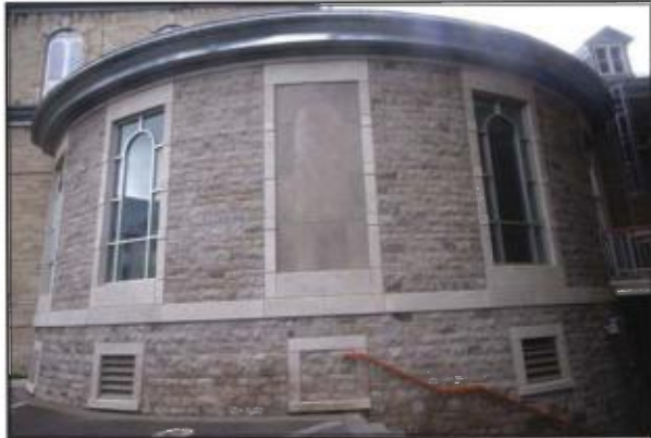
Cour du Séminaire : calcaire de Saint-Marc-des-Carières avec trois finis différents : éclaté, bouchardé et poli.
