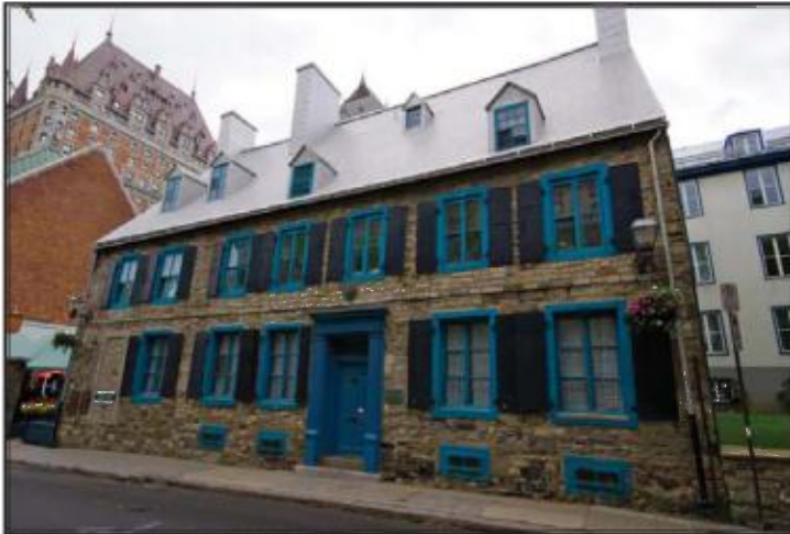
Maison Maillou : façade revêtue de moellons de grès de l'Ange-Gardien et de Sillery, de pierre noire du Cap et de calcaires de Beauport et de Pointe-aux-Trembles.
