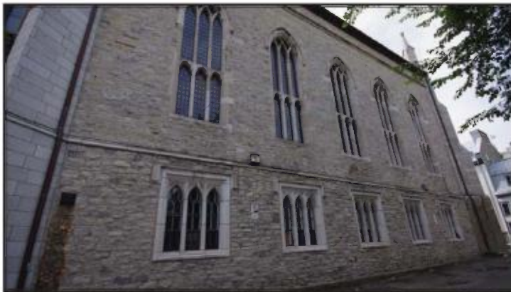
Mur latéral du côté nord en moellons de calcaire de Beauport; l'encadrement des fenêtres carrées est en calcaire de Saint-Marc-des-Carières.
