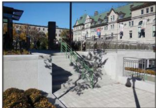
Terrasse de l'Hôtel de ville au-dessus du stationnement souterrain recouverte de granit Gris Saint-Sébastien et de dalles de granits Noir Cambrien et Picasso.
