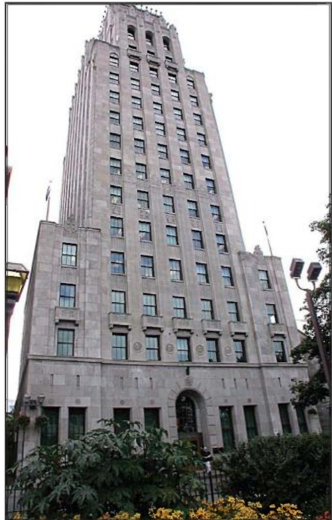
Édifice Price revêtu en partie de calcaire de Saint-Marc-des-Carières, en partie de calcaire de Queenston. Des panneaux de Queenston ont été remplacés par du calcaire d'Indiana en 2012.
