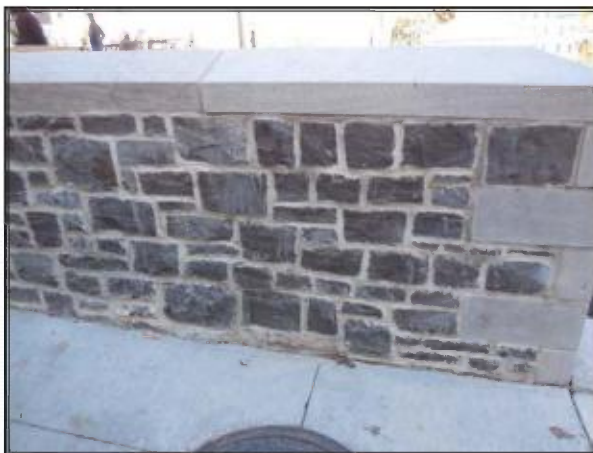
Muret rue Sainte-Anne en moellons de calcaire de Château-Richer, chaperon et chaîne d'angle en calcaire de Saint-Marc-des-Carières.
