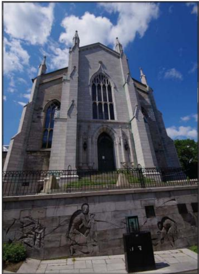
Institut Canadien : avant-corps, contreforts, pinacles, fleurons et paroi du parvis en calcaire de Saint-Marc-des-Carières.
