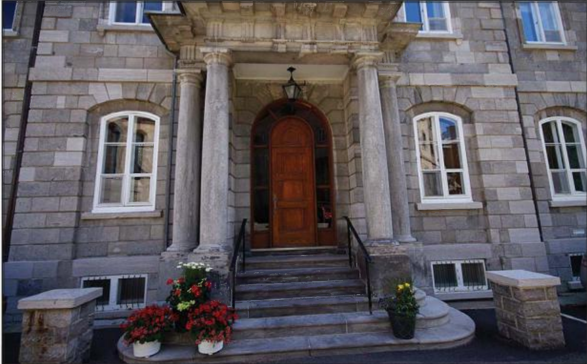
Palais archiepiscopal : portail de la rue du Parloir avec entablement et colonnes doriques en calcaire de Pointe-aux-Trembles. Les pierres architecturales (gris foncé) des murs sont en calcaire de Pointe-aux-Trembles, les pierres de remplacement (gris pâle) sont en calcaire de Saint-Marc-des-Carrières.
