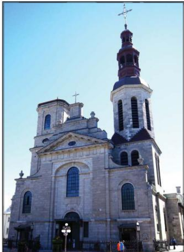
Basilique-cathédrale Notre-Dame de Québec : façade construite en 1843-1844 en calcaire de Pointe-aux-Trembles, partiellement remplacé par du calcaire de Saint-Marc-des-Carières après l'incendie de 1922.
