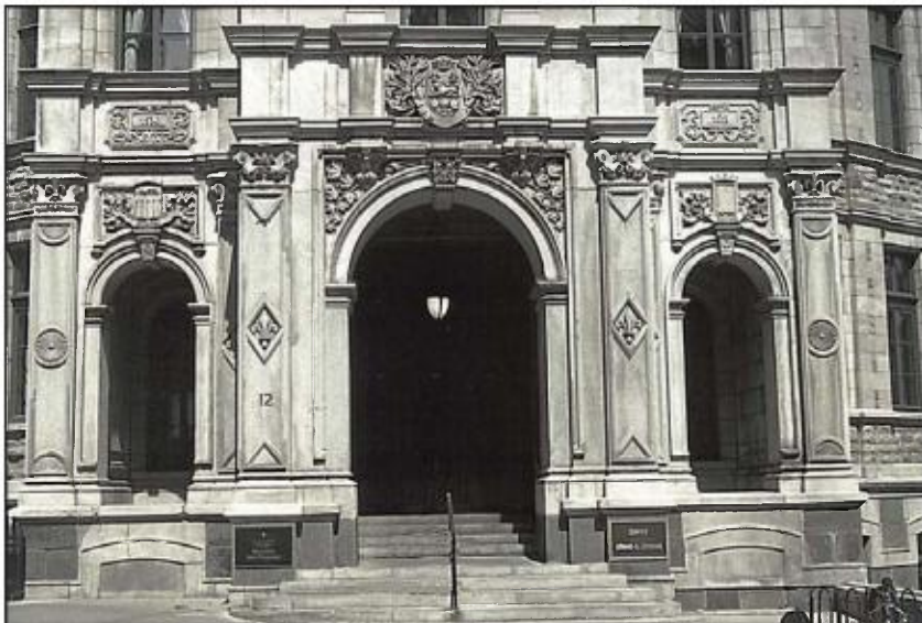
Portique de l'ancien palais de justice de Québec : pilastres en granite Gris Stanstead; arcades, tympan, armoiries et chapiteaux en calcaire de Saint-Marc-des-Carières; embasement en granit Calédonia de Rivière-à-Pierre substitué au grès de Sillery.
