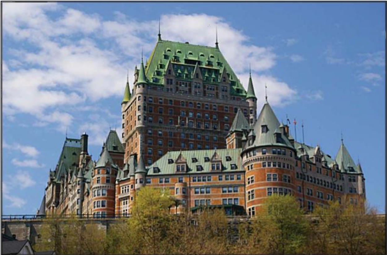
Château Frontenac : bandeaux, encadrements, corniches, poivrières et rez-de-chaussée en calcaire de Saint-Marc-des-Carières.
