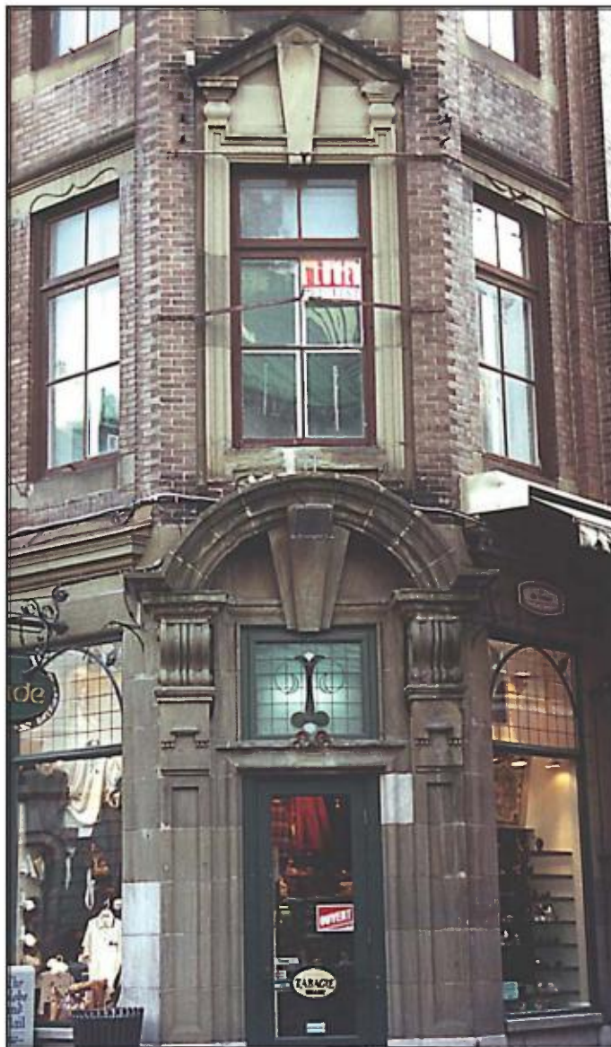
Façade en coin de l'édifice du Daily Telegraph ornementée de grès vert olive de Bouctouche (Miramichi) du Nouveau-Brunswick. Les pierres de remplacement de couleur beige pâle sont en calcaire d'Indiana.
