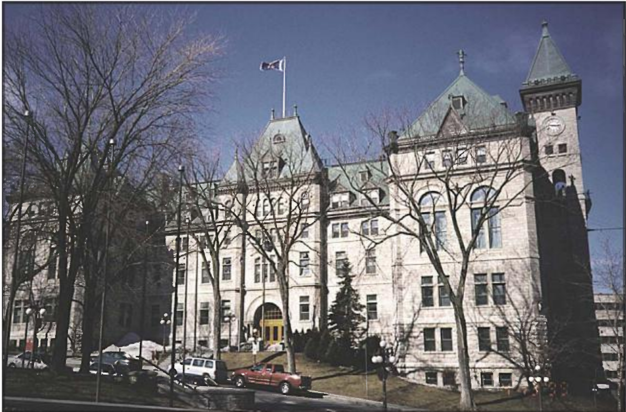
Hôtel de ville de Québec revêtu de calcaire de Saint-Marc-des-Carières avec divers finis : bossagé, éclaté, bouchardé et pointé par trait.
