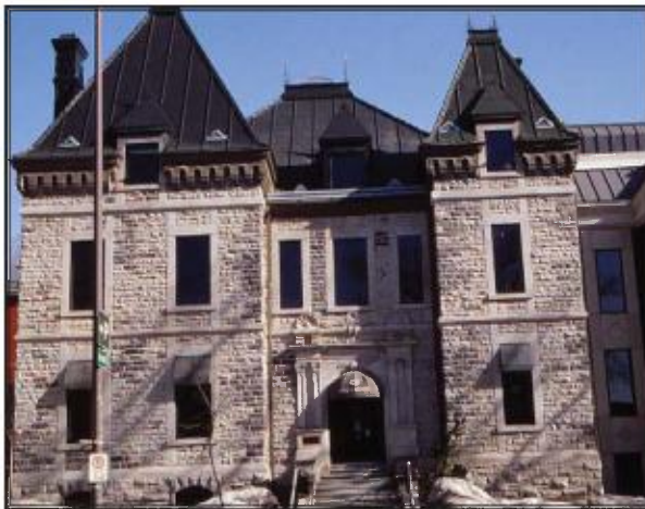
Édifice du 333, Grande Allée Est en calcaire de Château-Richer bossagé, avec encadrements des ouvertures, embasement et bandeaux en calcaire de Saint-Marc-des-Carières.
