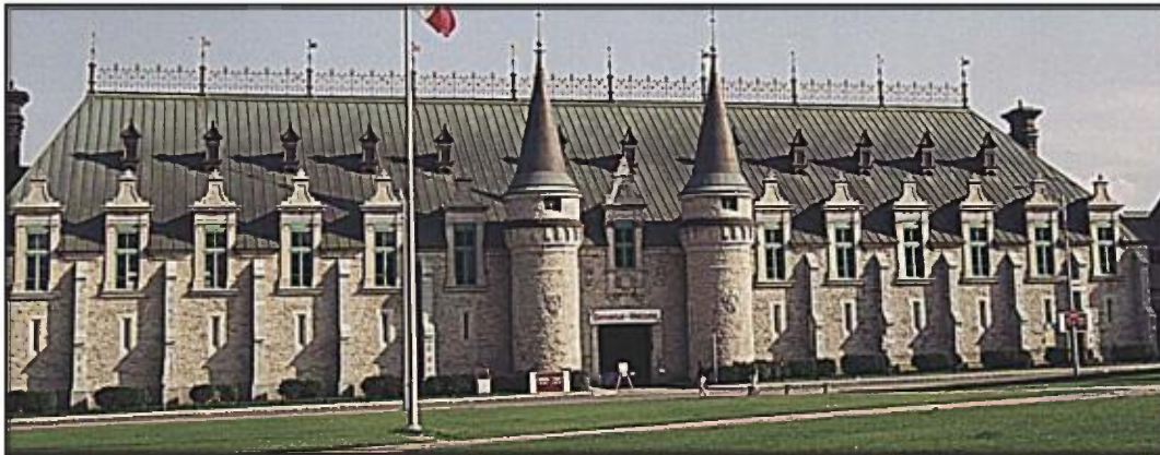
Manège militaire en calcaire de Beauport et ornements en calcaire de Saint-Marc-des-Carières avant l'incendie qui a éclaté dans la nuit du 4 au 5 avril 2008.
