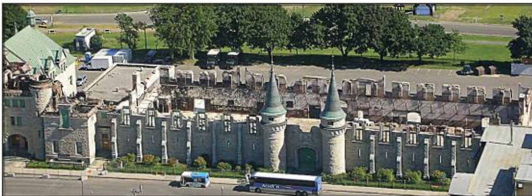
Vestiges du Manège militaire incendié au cours de la nuit du 4 au 5 avril 2008.
