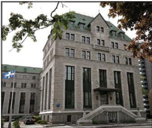
Édifice Guy-Frégault : murs en granite Gris Saint-Sébastien; encadrements en calcaire de Saint-Marc-des-Carières; base en granit Gris-Rose de Rivière-à-Pierre.
