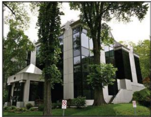
Annexe ouest en granite Écorce de Bouleau et colonnes du portail en granit Noir Cambrien.
