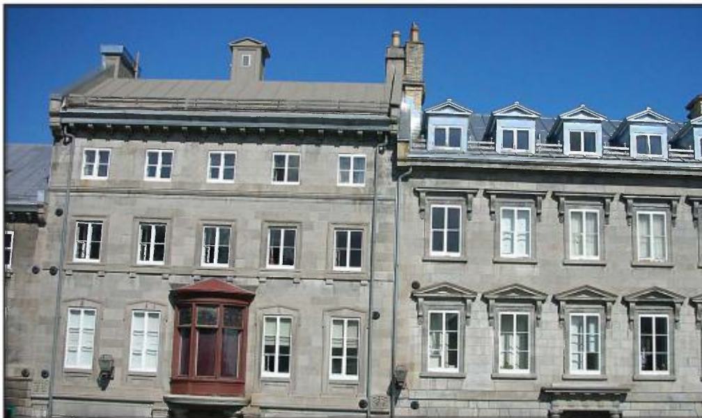
Maisons du 16 en calcaire de Montréal et du 14 en calcaire de Pointe-aux-Trembles.
