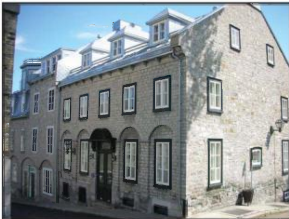
Maisons des 33, 35 et 37 rue de la Porte revêtues de calcaire de Château-Richer. Embasement en calcaire de Pointe-aux-Trembles.
