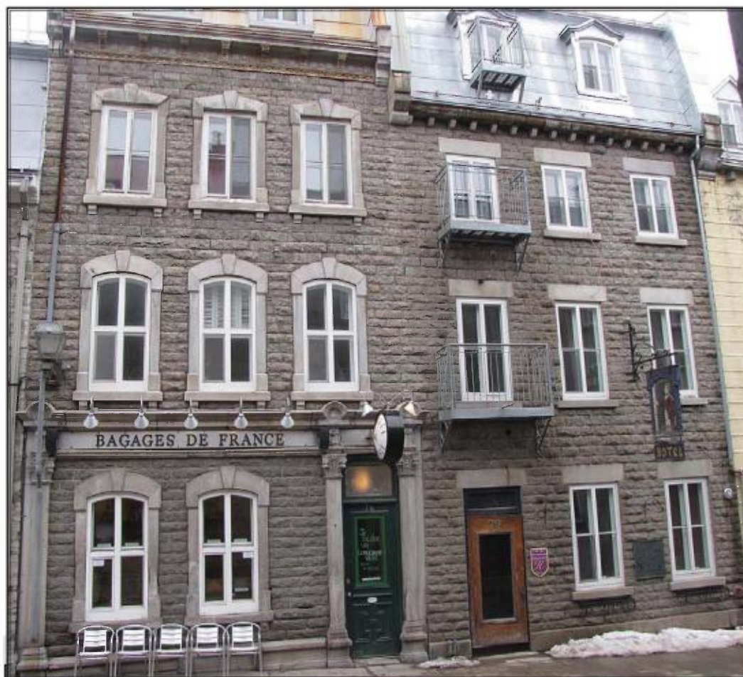
72, rue Saint-Louis, maison du Général en granit Gris-Rose de Miguick et encadrements des ouvertures en calcaire de Saint-Marc-des-Carières.
