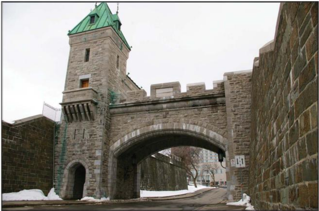
Porte Kent en calcaire de Saint-Marc-des-Carières bossagé et uni bouchardé.
