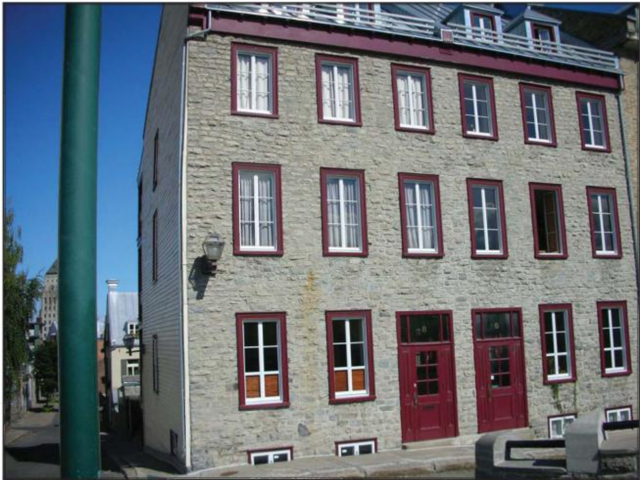
Maison des 6 et 8, avenue Saint-Denis en calcaire de Beauport.
