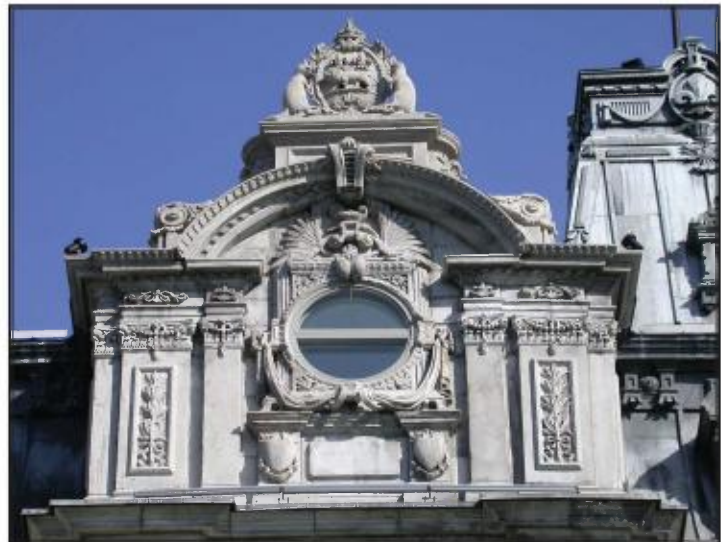
Sommet d'un pavillon d'angle de la Grande Allée orné de fines sculptures sur calcaire de Saint-Marc-des-Carières et coiffé d'un écusson des armoiries du Québec supporté par deux castors dressés.
