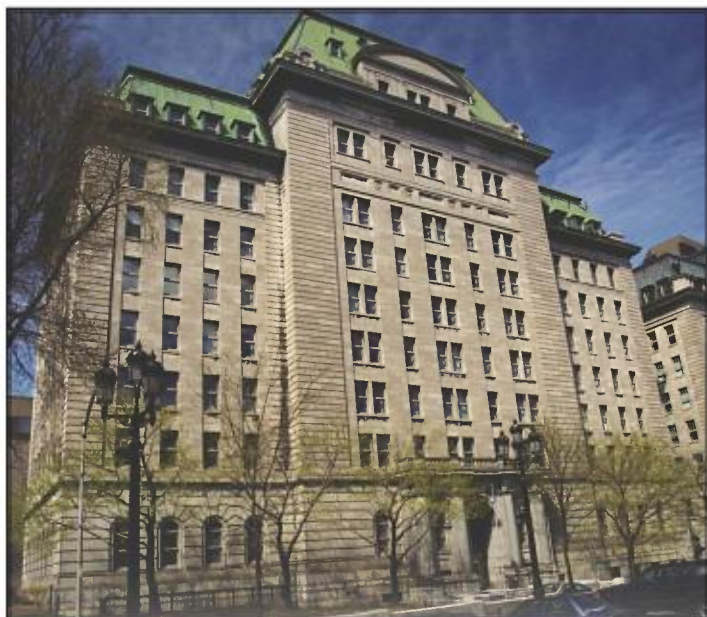
Édifice André Laurendeau : rez-de-chaussée en granite Gris Saint-Sébastien; colonnes, chapiteaux, entablement et balustrade du portail en granite Gris Stanstead; et les sept étages supérieurs, en calcaire de Saint-Marc-des-Carrières.
