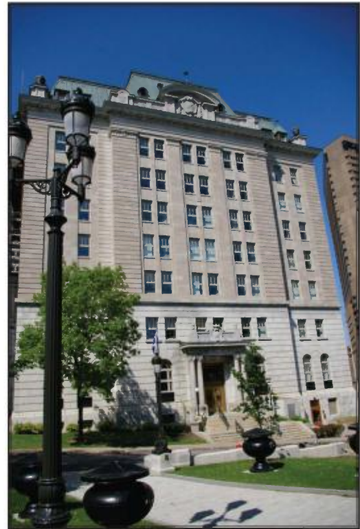
Édifice Jean-Antoine-Panet : le rez-de-chaussée et le premier étage sont en granite Gris Scotstown; les colonnes, les chapiteaux, l'entablement, le parapet, le cartouche et les urnes, en granite Gris Saint-Sébastien; et les cinq étages supérieurs, en calcaire de Saint-Marc-des-Carières.
