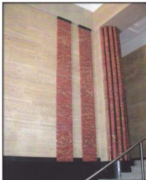
Hall d'entrée : murs en travertin et en marbre Noir Missisquoi, à la base; pilastres et colonnes en marbre Rouge de Vitrolles; marches et plancher, en marbre Gris Missisquoi.
