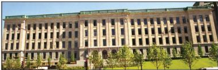
Édifice Honoré-Mercier : embasement en granite rouge de Charlesbourg; rez-de-chaussée en granit Gris-Bleu de Rivière-à-Pierre ; et étages supérieurs en calcaire de Saint-Marc-des-Carières.
