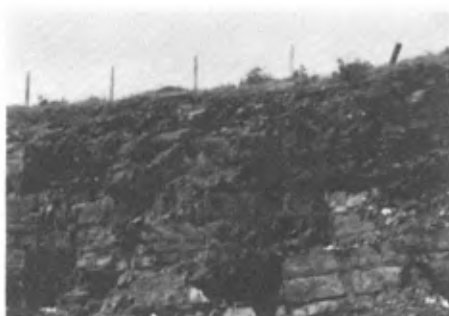
FIGURE 26 - Partie ouest de la carrière près de la gare de New-Carlisle.
