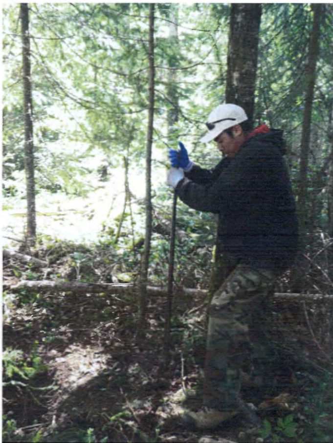
SB effectuant des trous à l'aide d'une crow bar pour insérer les explosifs afin de dynamiter le mort-terrain
