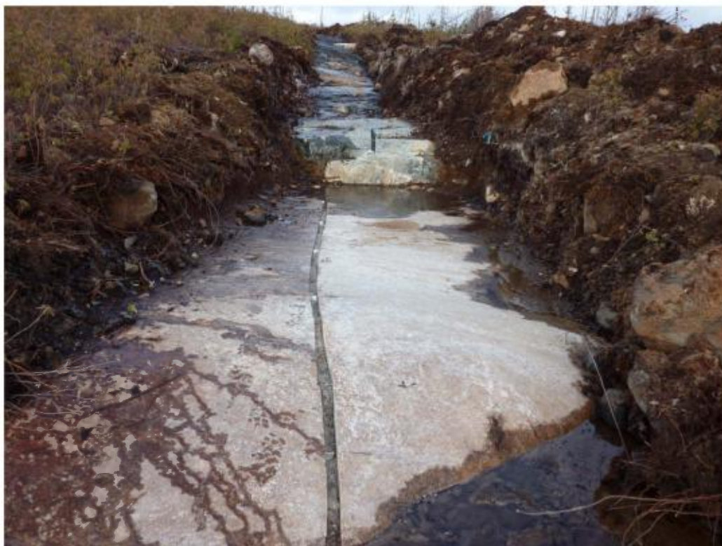
Figure 16: Rainure dans tranchée
