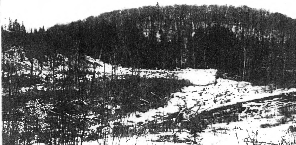
Photo #8: Limite sud-ouest de la zone de décapage indiquée par les rubans jaunes.
