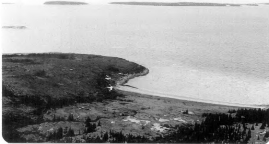
CETTE PHOTO MONTRE LA POINTE DE TERRE D'OU PARTIRAIT LE QUAI DE CHARGEMENT
