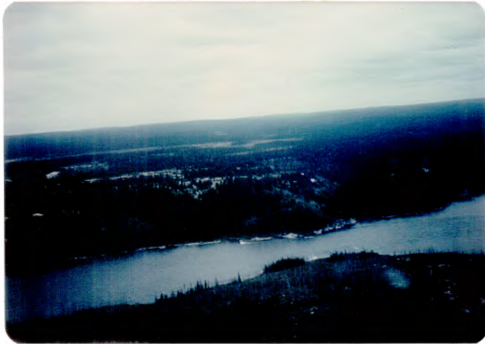
SITE DU PONT ENJAMBANT LA GRANDE RIVIERE DE LA BALEINE
