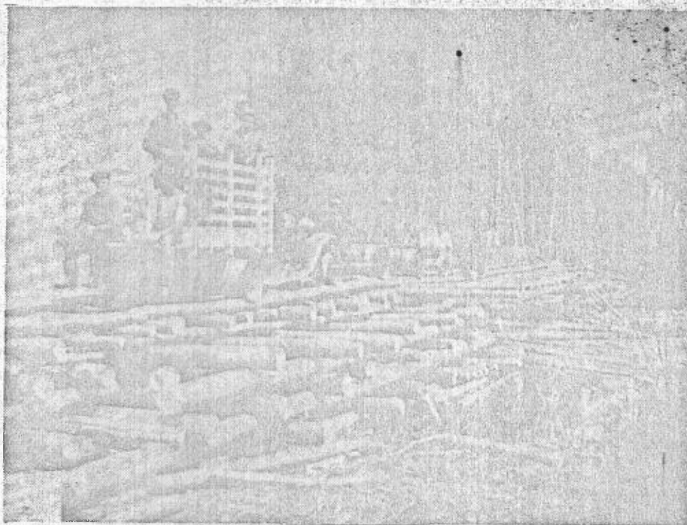
La mine naissante East Sullivan bénéficie grandement d'une idée originale, une "pole track" aux deux bouts de la grande concession, pour le transport rapide des hommes et du matériel. La rivière Bourlambaque présentait un problème particulier.
