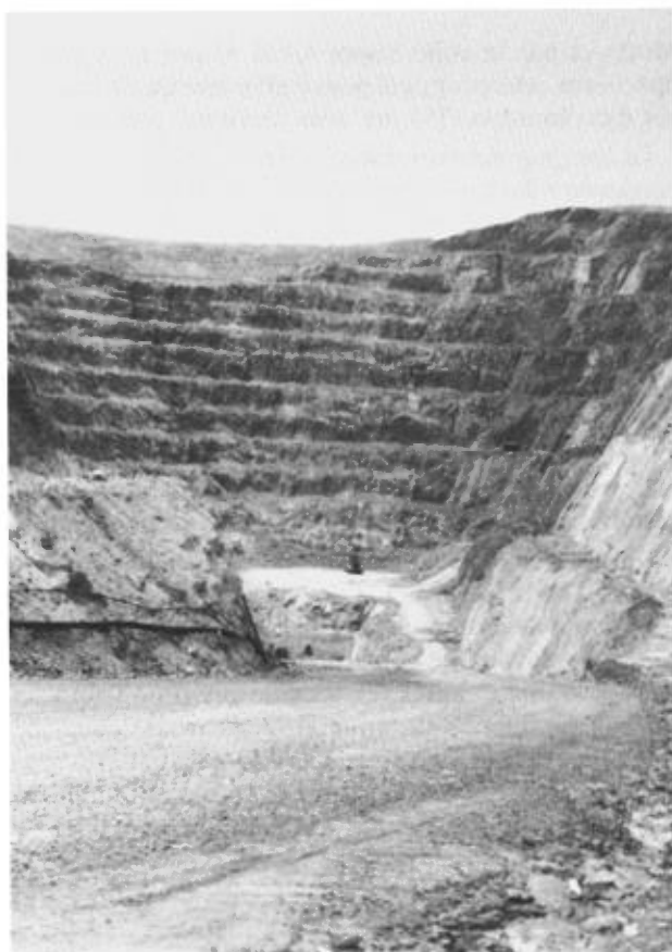
FIGURE 1 — Vue de la partie ouest de la fosse à ciel ouvert.
