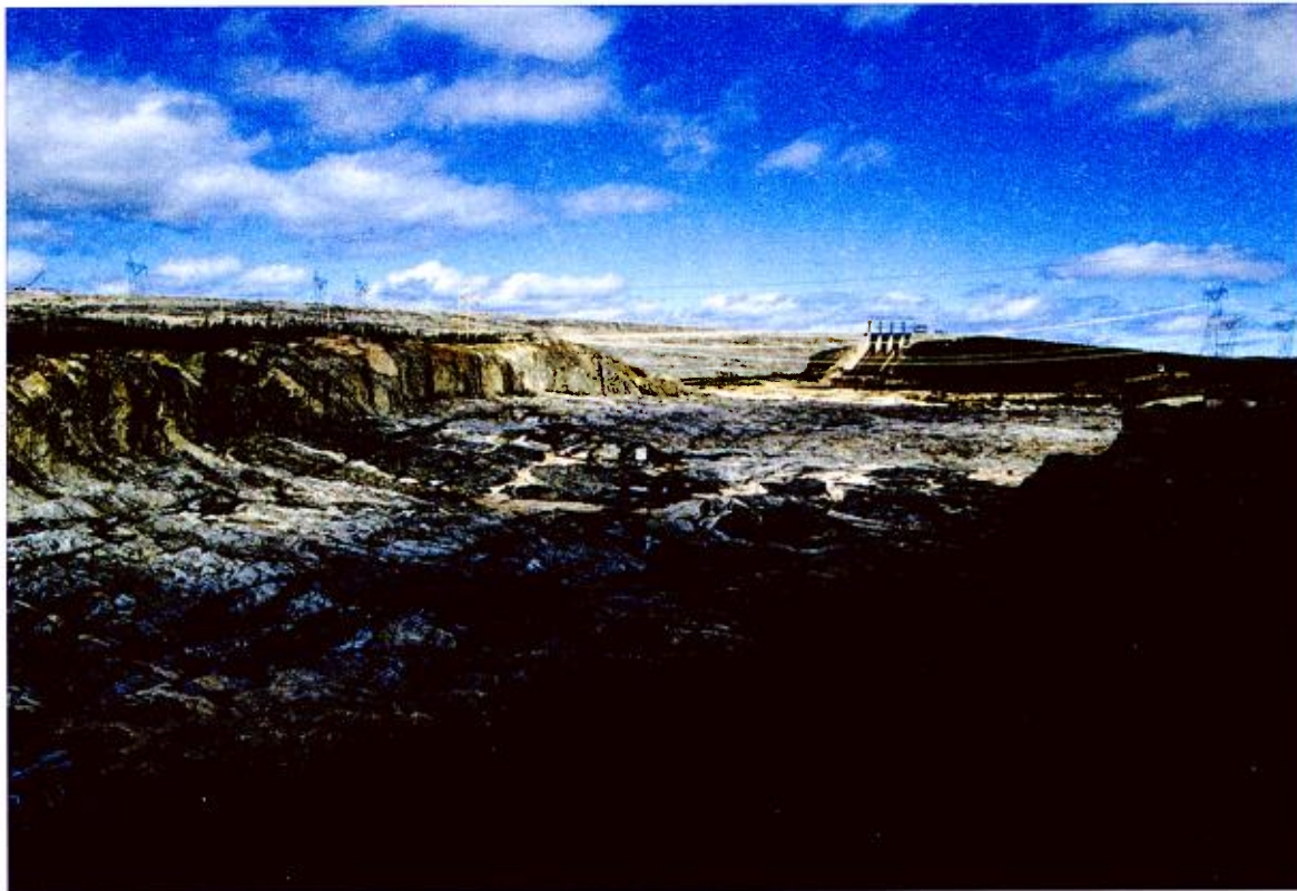
Vue de l'évacuateur de crue de la centrale LG4, donnant sur les tonalites foliées de la sous-province de la Grande
