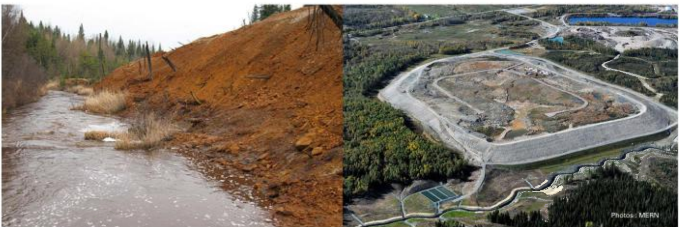
Site minier Barvue, le ruisseau Marcotte avant la restauration (résidus épanchés lors de la rupture de la digue).
