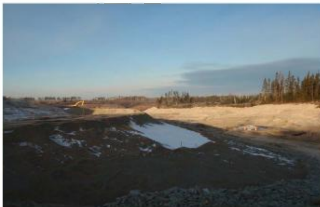
Site minier Barvue, construction de la berme.
