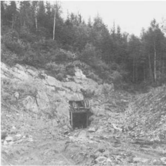
FIGURE 53 - Entrée de la galerie à flanc de coteau de l'ancienne mine Norbeau.
