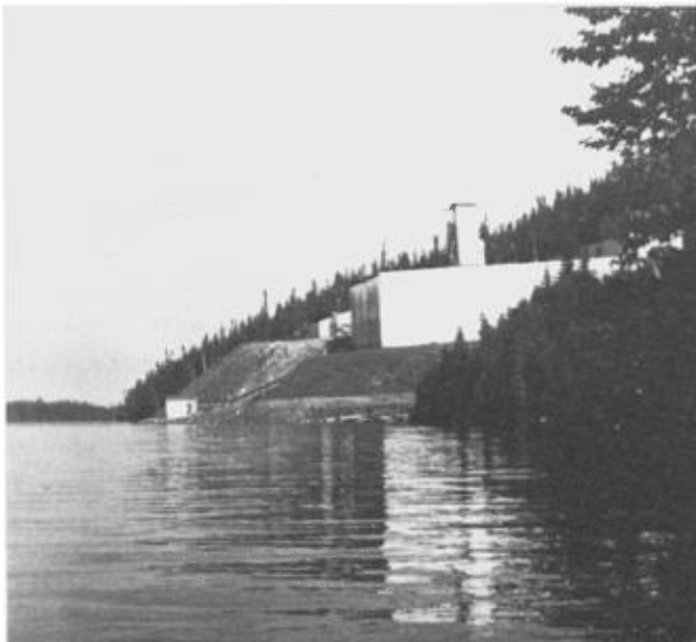
FIGURE 52 - Chevalement et ateliers de l'ancienne mine d'or Norbeau (propriété Beaurox). Rang VI, quart nord-est de McKenzie.
