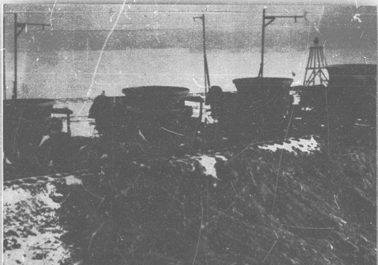
Déchargement de la scorie à la fonderie de Noranda. Mélangée aux stériles qui proviennent de l'atelier de traitement, la scorie granulée sert à la mine Horne comme matériel de ramblayage. Photo: Associated Screen News.
