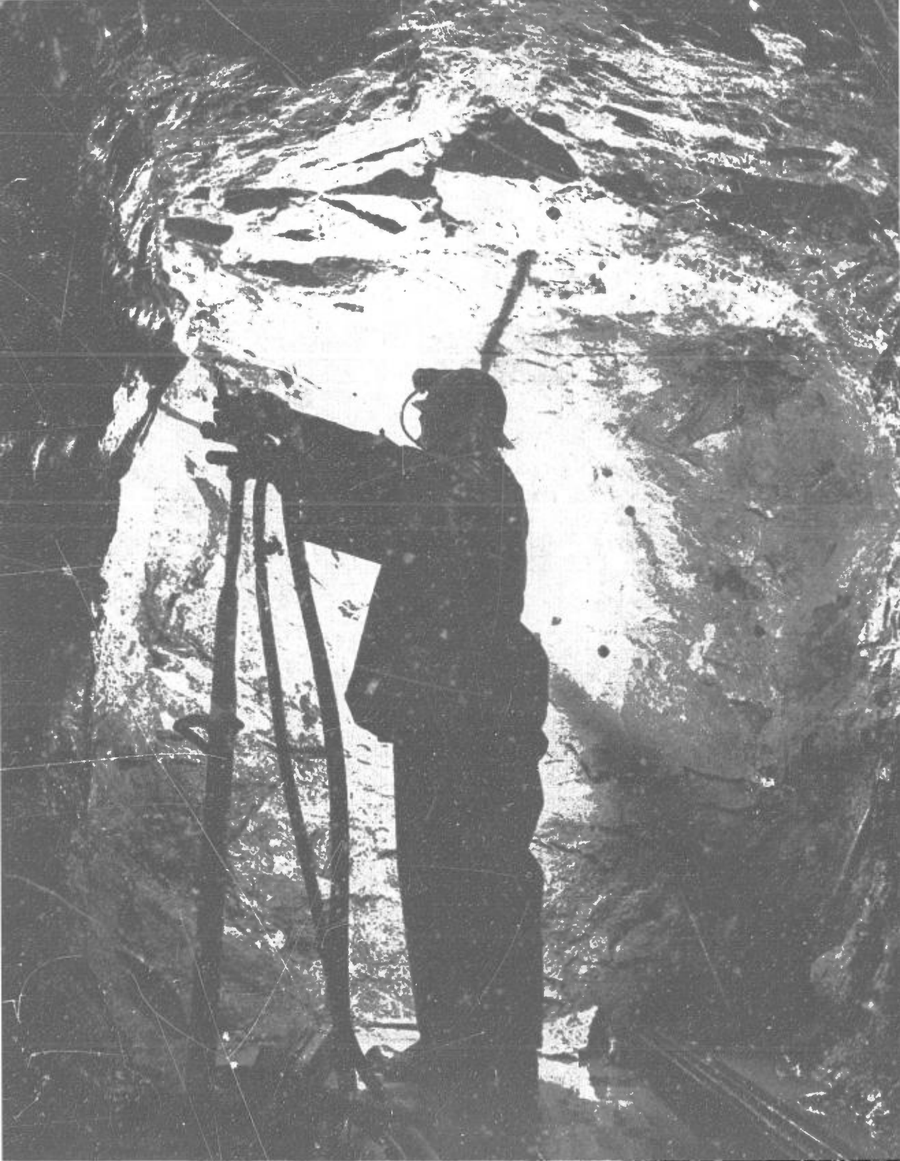
Forage de trous de mine dans un chantier souterrain de la mine d'amiante Jeffrey, à Asbestos, dans les Cantons de l'Est. On garnit ensuite les trous d'explosifs, que l'on fait sauter pour abattre la roche. Courtoisie de Canadian Johns-Manville company Ltd. Photo: George Hunter.
