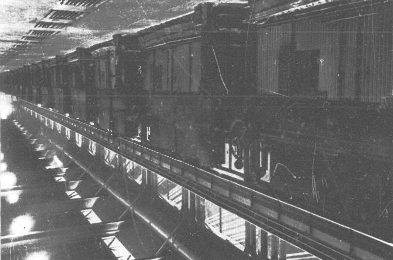
Batterie de cuves d'électrolyse à l'usine d'aluminium d'Arvida. Courtoisie d'Aluminum Company of Canada Ltd.
