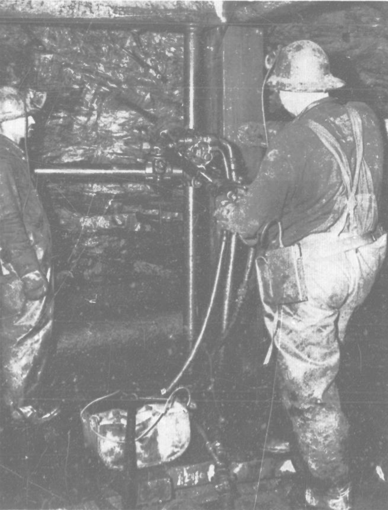
Forage de trous de mine dans un chantier d'abatage à boisage quadrillé dans la mine Normetal dans l'Ouest de Québec. Avec ce système d'exploitation, le toit et les parois de l'excavation sont soutenus par un ensemble de pièces de bois horizontales et verticales disposées en forme de cubes creux.
