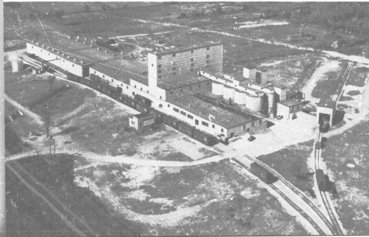
Fabrique de briques réfractaires à Marelan, dans le Sud de Québec. Les matériaux réfractaires que produit cette usine servent à construire des revêtements intérieurs de fours métallurgiques et industriels. Courtoisie de Canadian Refractories Ltd. Photo: Max Sauer.
