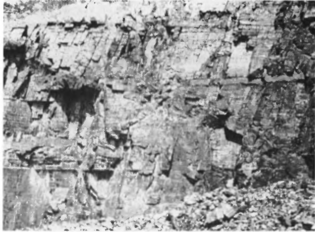
FIGURE 72 — Vue rapprochée de la face NE de l'ancienne carrière Potvin. À noter les diaclases de direction 6° et l'enchevêtrement des filons-couches qui forme un «X» couché.
