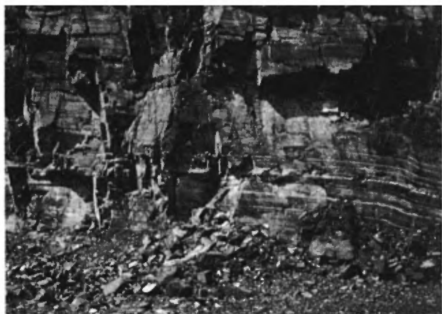
FIGURE 65 — Vue rapprochée de la face nord du premier palier inférieur de la carrière Mont-Bruno n° 2 Dulude. À noter l'ondulation du litage ainsi que les diaclases d'une direction de 110^\circ et à pendage de 82^\circ NE.
