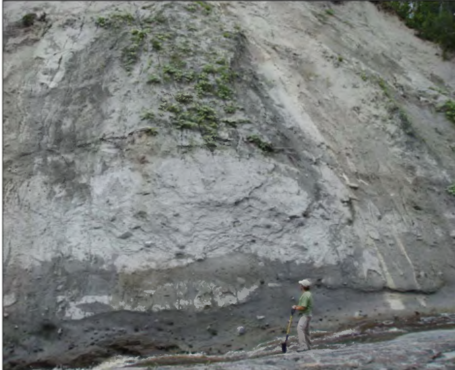
Figure 8. Coupe le long de la rivière aux-Vases montrant un till massif à la base (Tc) recouvert par une couche d'argile glaciomarine (MGa) affectée par un glissement de terrain. Le plan de glissement est souligné par la présence de débris d'arbres; 12 km au nord de ville de Saguenay (carte 22D06). Photo 09EL08074a.
