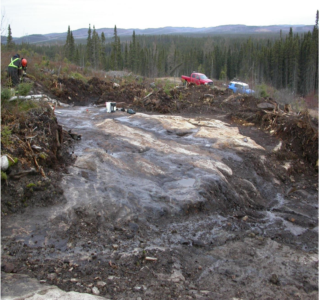
Résultat partiel du plus important décapage (Zone Ouest).
