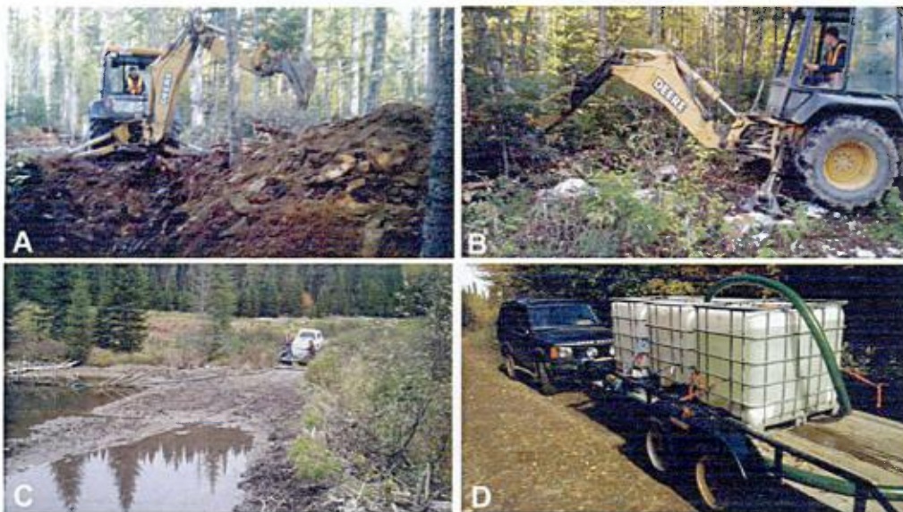
Figure 7. Photographies de terrain montrant le nettoyage et l'élargissement d'anciennes tranchées (A et B) et le dispositif d'acheminement de l'eau (C et D).
